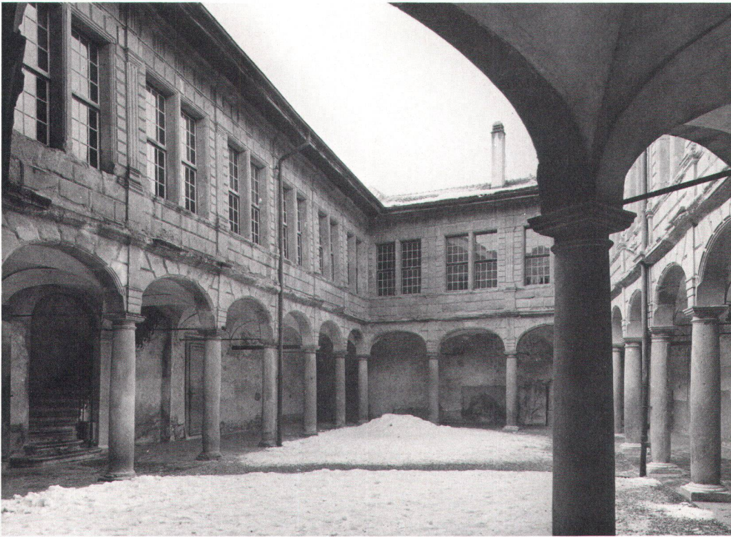
La durée des parties d'une construction dépend aussi de la qualité de son entretien (photo Vuilliemin, la cour du château d'Aubonne VD)
