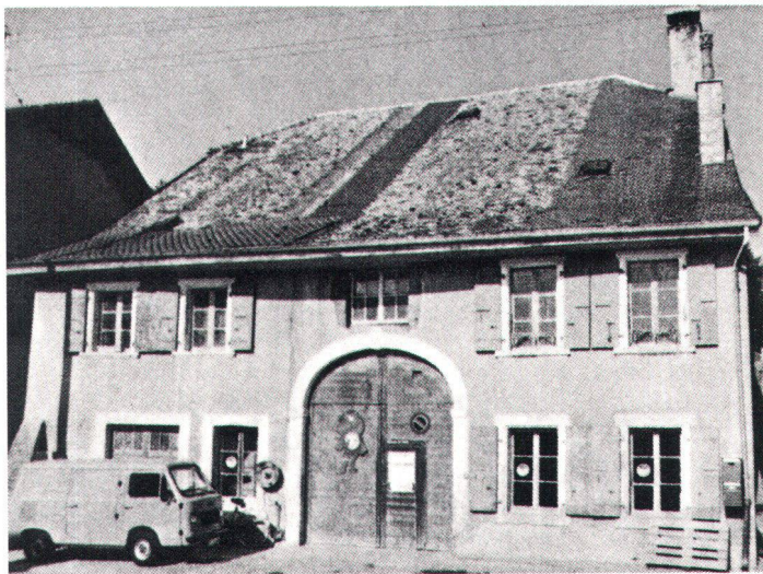
L'unité d'un toit est rompue quand les nouvelles tuiles n'ont ni la même teinte, ni la bonne disposition (photos Section des monuments historiques VD).
