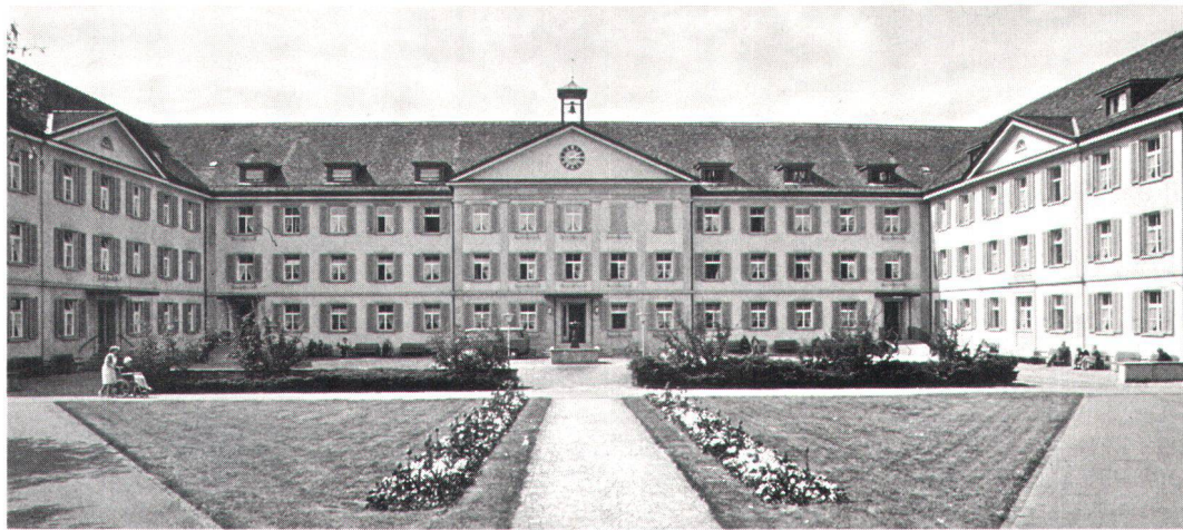
Heute ist die ehemalige Spinnerei Wülflingen ein Krankenhaus (Bild Schmidt). L'ancienne filature de Wülflingen est maintenant un hôpital.
