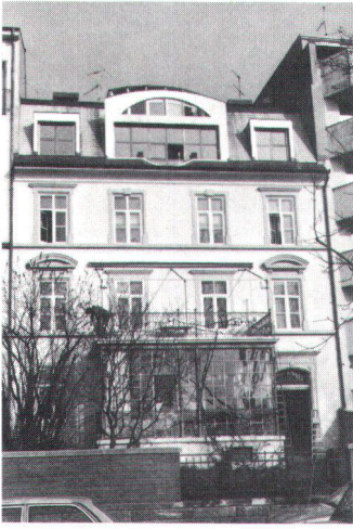
1981 vom Basler Heimatschutz ausgezeichnete Dachstockausbau mit Wintergarten-Verglasung (Bild Koepp).
