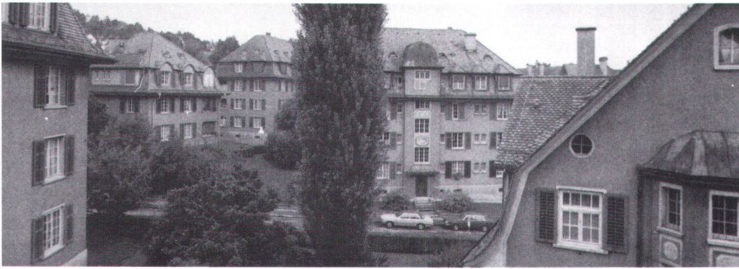
Das 35-Millionen-Kreditbegehren der Stadtverwaltung Zürich für eine umfassende Sanierung der Siedlung lehnte die Bevölkerung deutlich ab (Bild Gygax).
