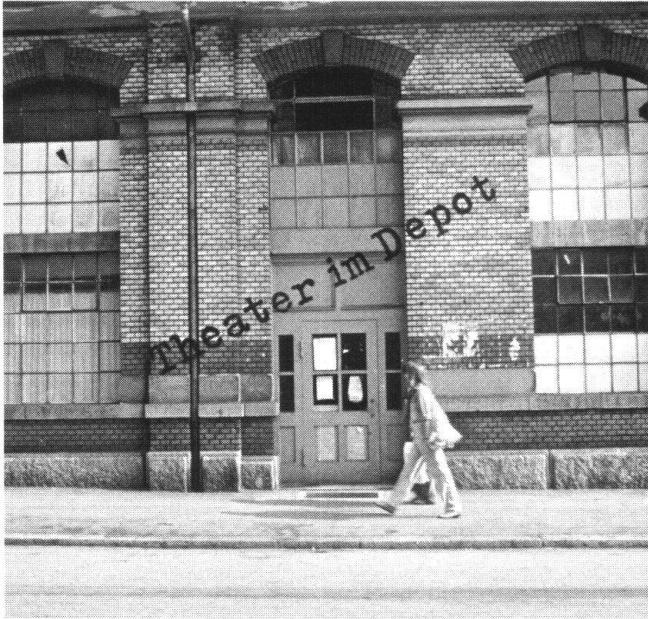
Dass das Abreissen nicht mehr benutzter Räumlichkeiten nicht die einzige Lösung ist, wird am Beispiel eines alten Zürcher Tramdepots im Seefeld-Quartier deutlich: Es wurde zum Theater umfunktioniert (Bild ORL-Institut der ETH).
