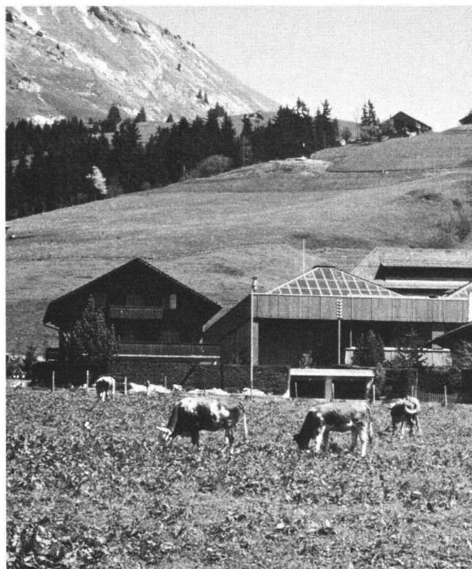
Le toit du nouvel hôpital de Château-d'Oex, composé de sept pyramides, est équipé de 370 m 2 de collecteurs solaires (photo SSES).
