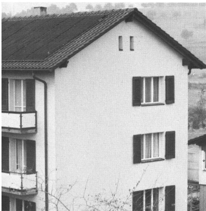
In Baar hat die Stiftung Sonnenenergiehaus Zug ein Mehrfamilienhaus auf Sonnenenergie umgebaut: Die Niedertemperaturkollektoren auf dem Dach, die Wärmepumpe und eine umfassende Nachisolierung haben den Ölverbrauch um 8000 Liter im Jahr gesenkt (Bild Ottiger).
