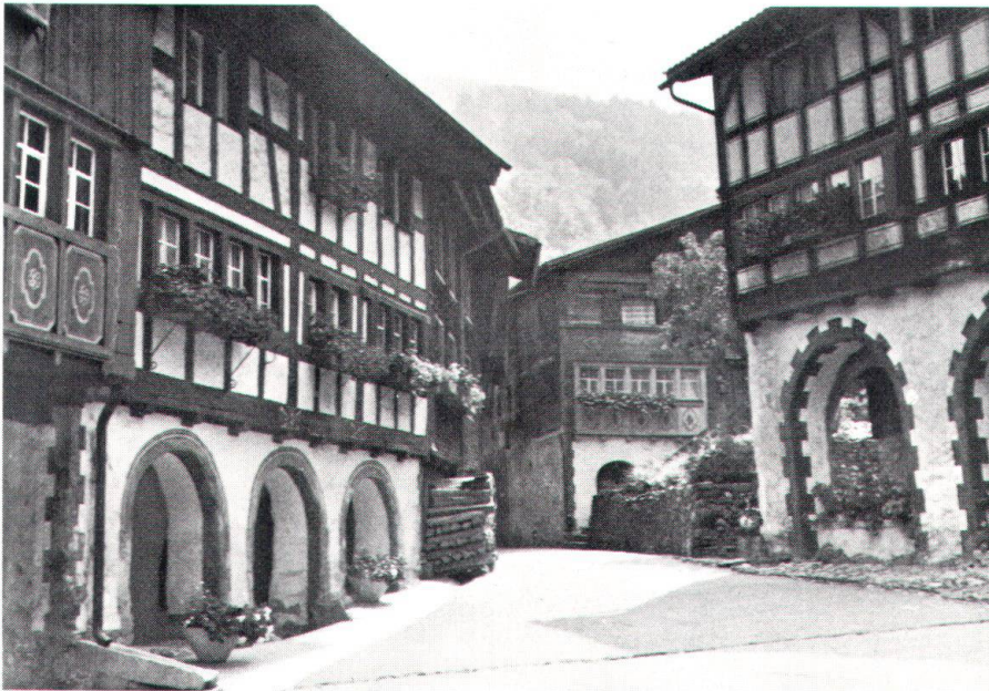
La place du Marché de Werdenberg après la rénovation des maisons médiévales (photo LSP).
