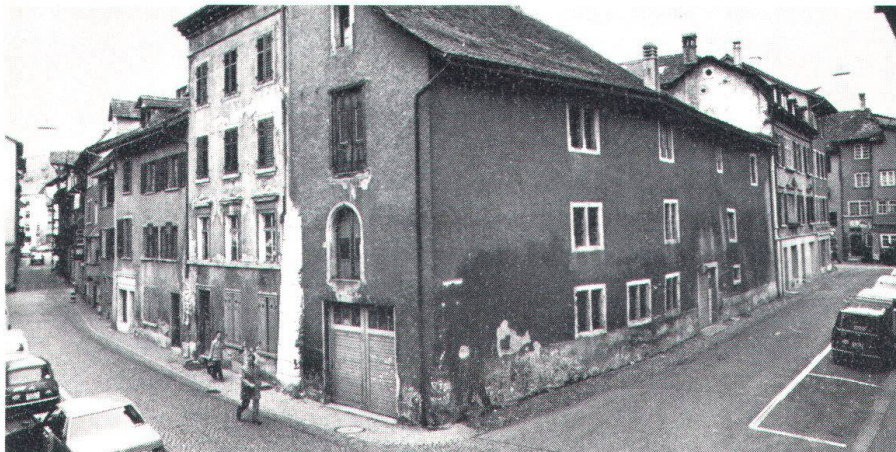
Hier an der Repfergasse in Schaffhausen sollte ein Neubau entstehen. Hinter den vernachlässigten Fassaden der dafür zu opfernden Altliegenschaften verbirgt sich eine kostbare Bausubstanz (Bild Baumann).
