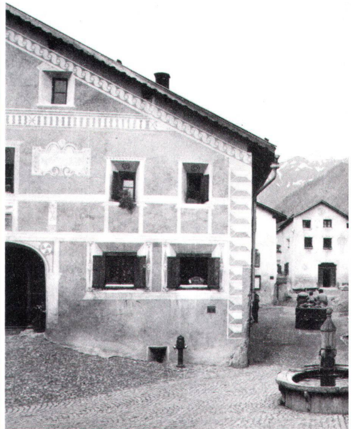
Dicke Mauern, kleine Fenster in Berggegenden, Holz als Baumaterial, die Lage des Hauses in Bezug auf die Sonneneinstrahlung – unsere Vorväter waren energiebewusste Architekten. Wir können von ihnen noch vieles lernen (Bild SHS).
