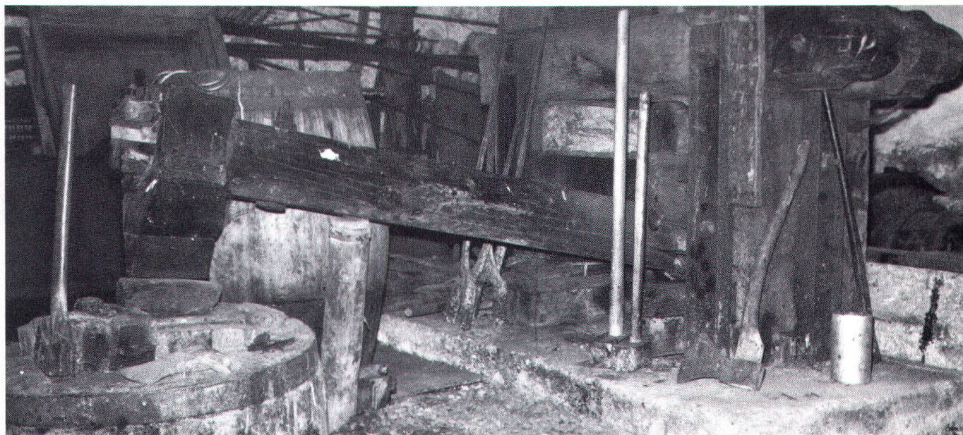
La roue à aubes de la forge de Corcelles actionnait deux marteaux (on en voit un ici), un tour et un soufflet (photo SHS).
