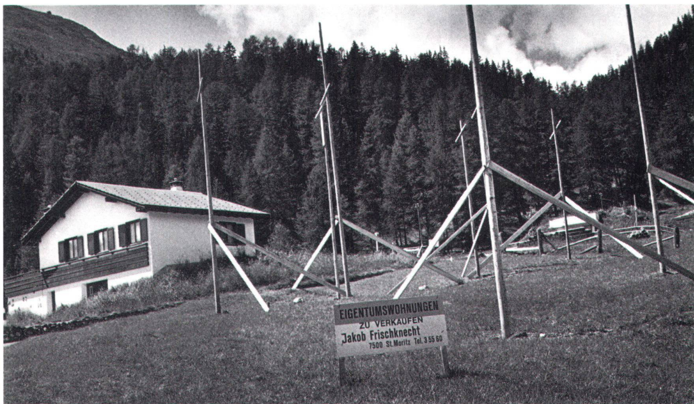
Impôt spécial de 1% sur toutes les opérations immobilières? (photo Schneider).
