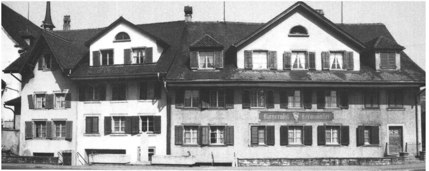
L'ancien asile des Bourgeois ferme à l'est la rue du Marché. Un projet est à l'étude pour le restaurer et lui donner une nouvelle affectation.
