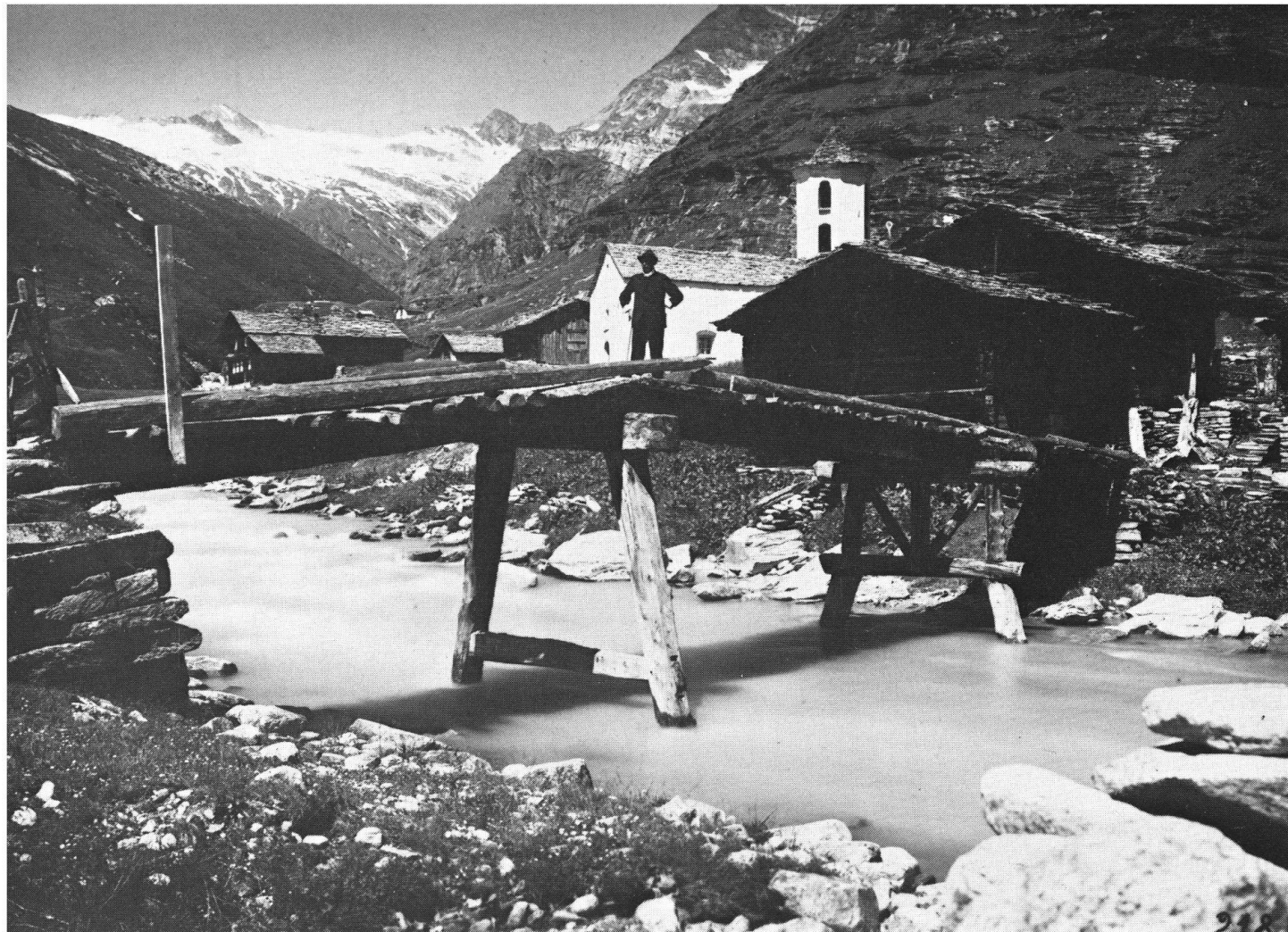
Ancien pont à poutres droites, sur chevalets, à Zervreila près Vals GR (photo de 1910). Les vestiges de ce petit village gisent aujourd'hui sous l'eau, dans un lac artificiel. Un pont analogue franchissait le Rhône près de Rarogne/St-German. Le pont lacustre de Rapperswil, qui de 1358 à 1878 relia la ville des roses au village de pêcheurs de Hurden, devait être du même type.
