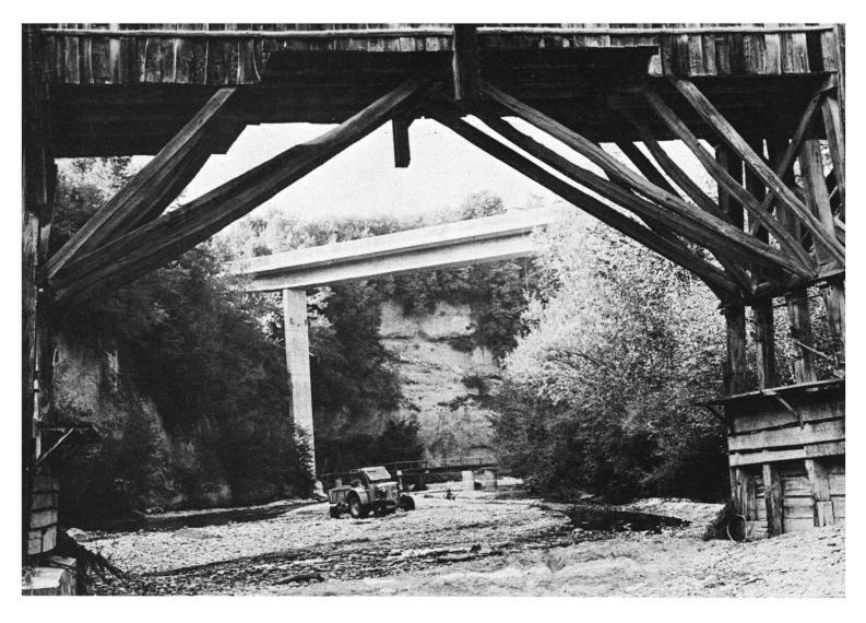
Un système à contre-fiches triangulaire soutient le «Letzibrücke», sur le Necker, près de Lütisburg SG. Les contrefiches se rejoignent au milieu du tablier, soutenu juste audessus des poutres par des chapeaux. Un pont de béton a maintenant relayé le pont de bois, fort mal en point, pour le passage du trafic.
