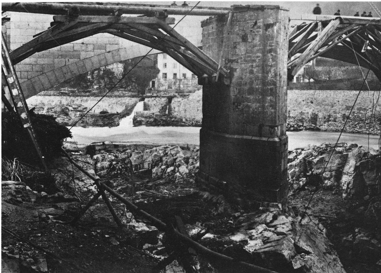
Système à contre-fiches trapézoïdal: le pont de bois non couvert de Laufenburg, sur le Rhin, pendant les travaux de démolition de janvier 1912. Le système porteur se trouvant, ici, tout entier sous le tablier, une superstructure n'était pas nécessaire.
