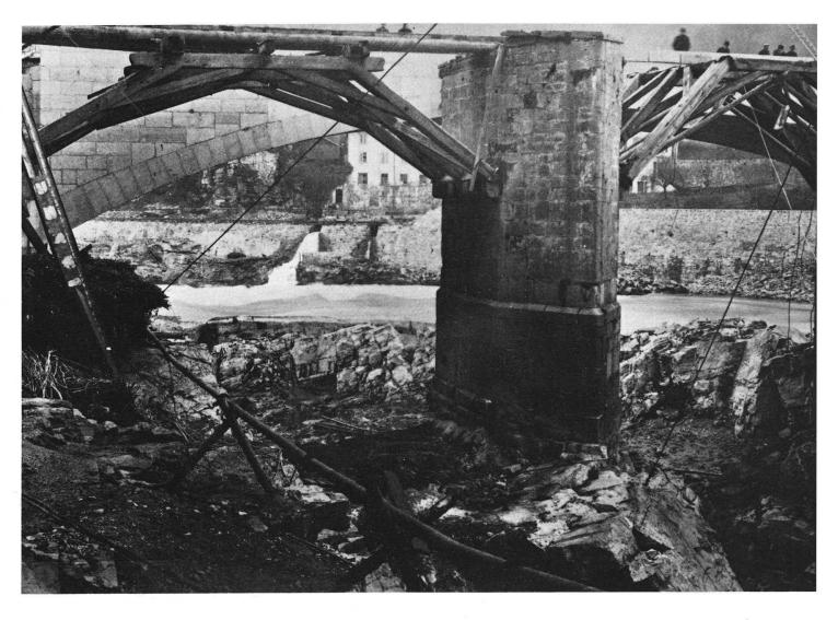
Système à contre-fiches trapézoïdal: le pont de bois non couvert de Laufenburg, sur le Rhin, pendant les travaux de démolition de janvier 1912. Le système porteur se trouvant, ici, tout entier sous le tablier, une superstructure n'était pas nécessaire.
