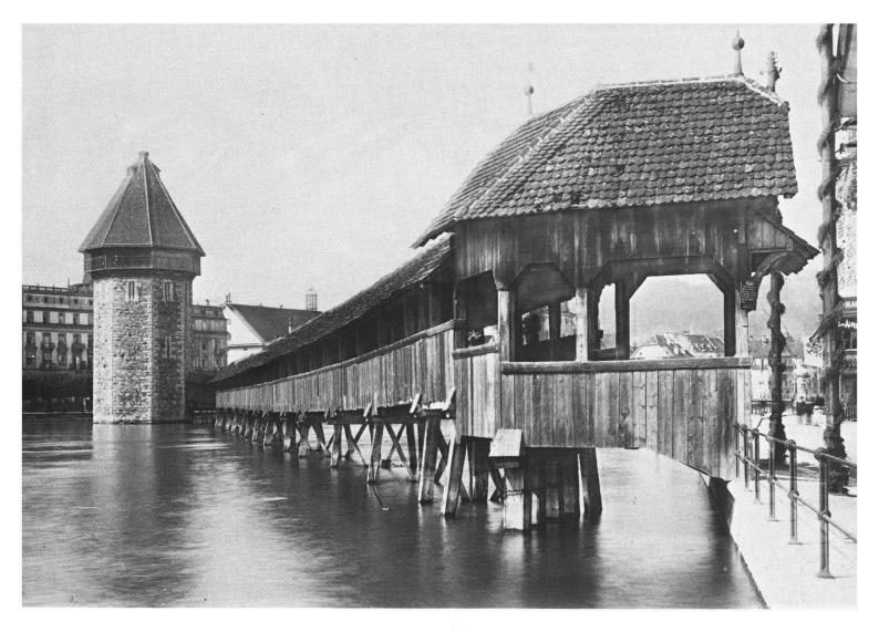
Des supports semblables, de forme trapézoïdale et renforcés par des croisillons, caractérisent le «Kapellbrücke» de Lucerne. La longueur moyenne des 28 travées est de 7 m 65. Cette petite distance entre les chevalets permet de se passer de contre-fiches ou de suspension. Au sud du «Wasserturm», le pont repose sur de petites piles de pierre quadrangulaires qui se rétrécissent légèrement vers le haut.
