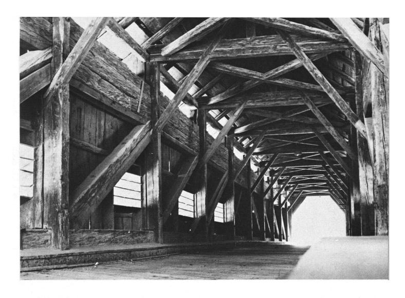
47 m lange Fachwerkbrücke über den Hinterrhein in Andeer GR (1856). Das Fachwerk ist in massive Streckbalken-Systeme eingespannt.
