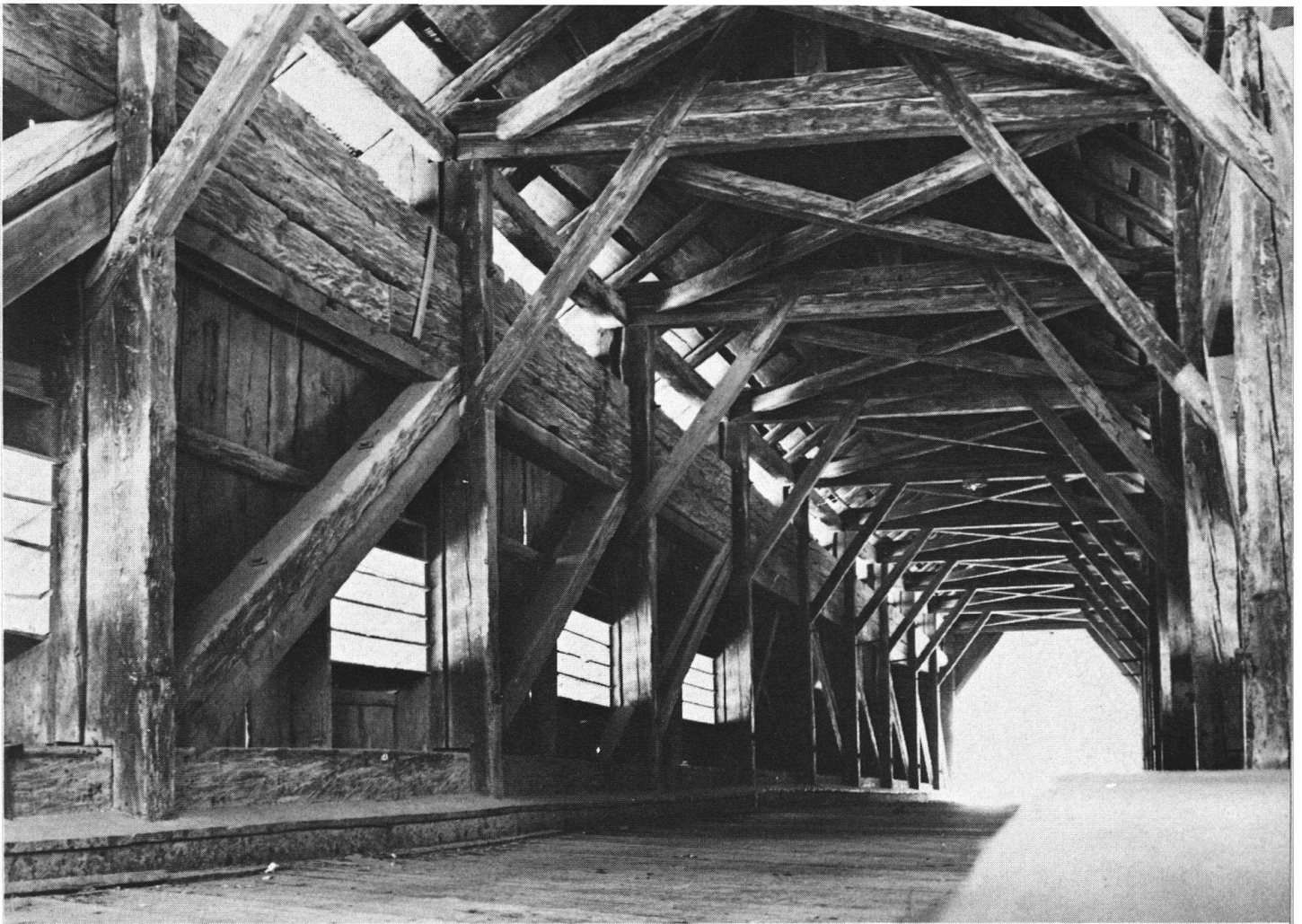
47 m lange Fachwerkbrücke über den Hinterrhein in Andeer GR (1856). Das Fachwerk ist in massive Streckbalken-Systeme eingespannt.
