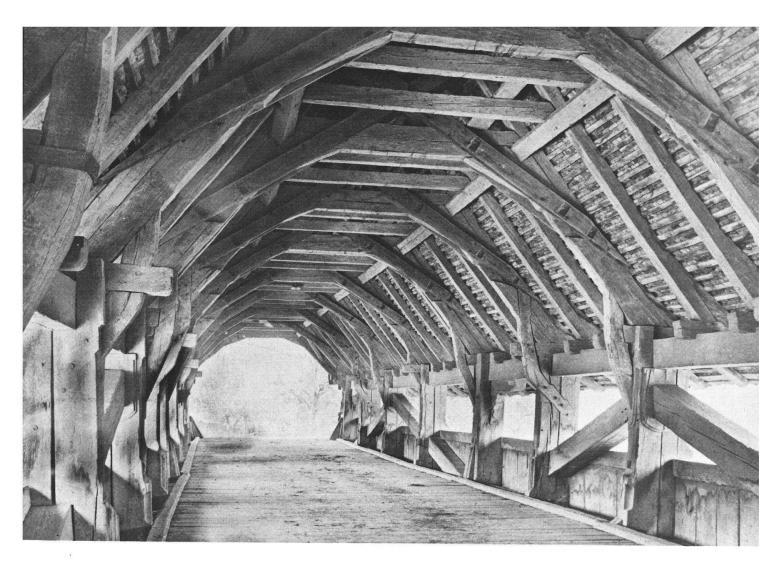
Inneres der Gümmenen-Brücke über die Saane bei Bern (1555). Unter dem massiven Berner Walmdach fügen sich Dachstreben und Bögen gleichsam zu einem Gewölbe (Aufnahme 1913).
