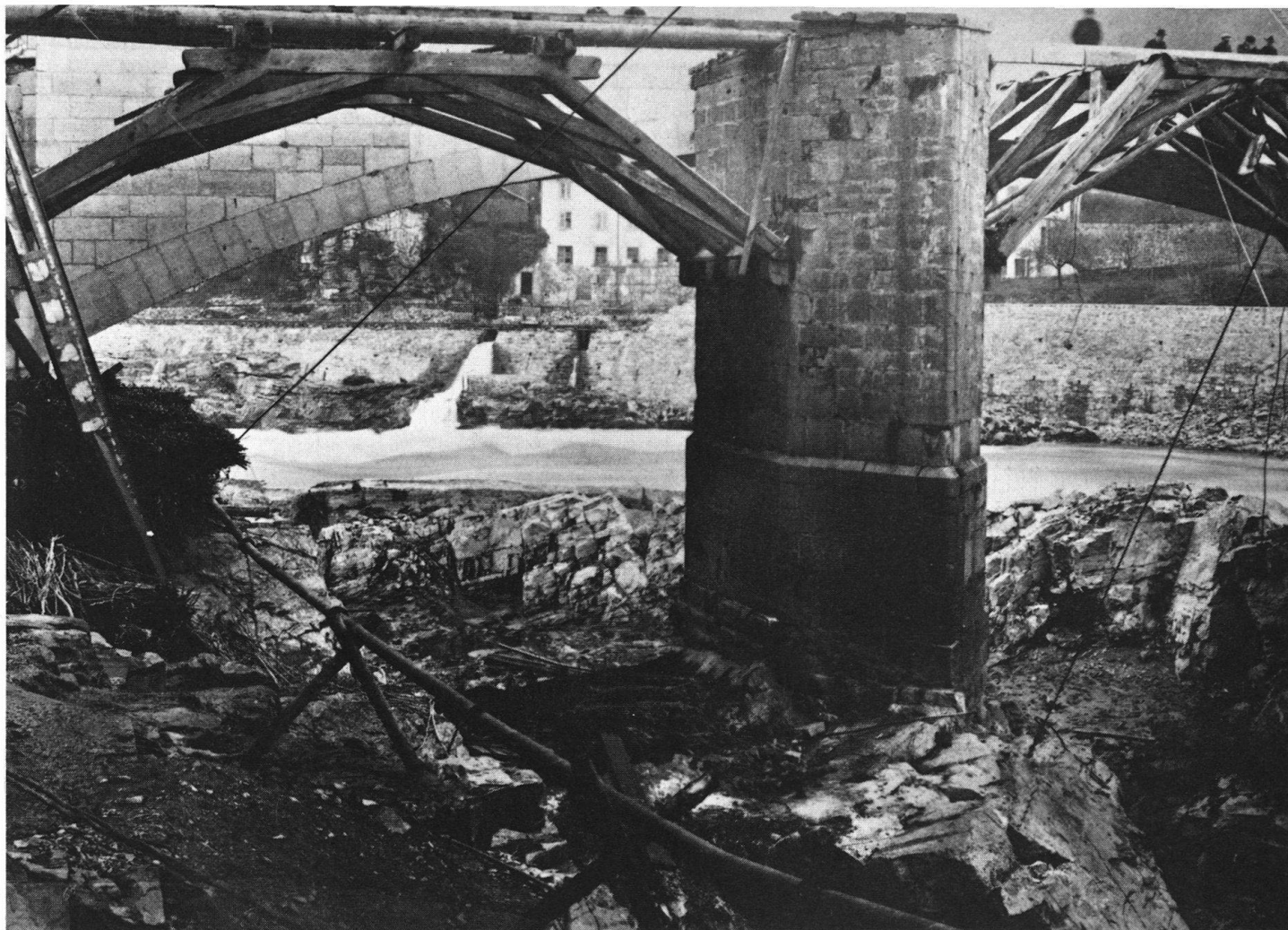
Trapezspengwerke der ungedeckten Holzbrücke über den Rhein in Laufenburg während der Abbrucharbeiten im Januar 1912. Da hier das gesamte Tragsystem unter die Fahrbahn zu stehen kam, erübrigte sich die Überdeckung.
