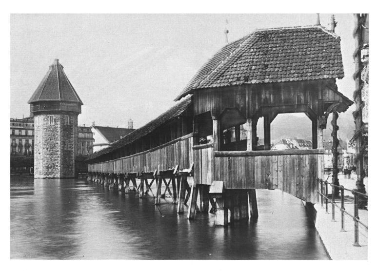
Ähnliche trapezförmige Pfahljoche mit diagonaler Verstrebung wie auf S. 8 kennzeichnen das System der Luzerner Kapellbrücke. Die durchschnittliche Weite der 28 Brückenöffnungen beträgt 7,65 m. Die geringe Distanz zwischen den einzelnen Pfahljochen erübrigt Spreng- oder Hängewerkkonstruktionen. Südlich des Wasserturmes ruht die Brücke auf quadratischen Steinpfeilerchen, die sich nach oben etwas verjüngen. (Literatur: A. Reinle, Die Kunstdenkmäler des Kantons Luzern, Bd. II, S. 86ff.)
