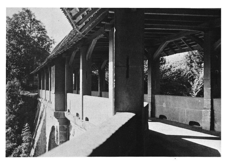
Als einzige Steinbrücke mit hölzernem Überbau bot die «Tüfelsbrugg» über die Sihl zwischen Einsiedeln und dem Etzel weithergereisten Pilgern angenehmen Unterstand. Alte Ansichten bestätigen die Überdeckung bereits im 16. Jahrhundert. Der Unterbau, zwei massive Tonnengewölbe mit Mittelpfeilern, wurde 1699 vom Einsiedler Klosterbaumeister Caspar Moosbrugger erneuert. Die jetzige Überdeckung mit den Sandsteinpfeilern dürfte etwas später als der Nepomukbildstock (1794) erstellt worden sein.
