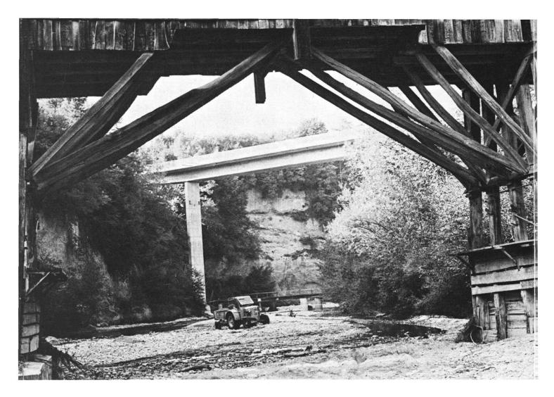
Dreiecksprengwerke im Unterbau der gedeckten Letzibrücke über den Necker bei Lütisburg SG. Die Druckstreben stossen die Fahrbahn in die Längsmitte. Unmittelbar über den Pfahljochen ist die Brückenbahn durch sog. Sattelhölzer und Kopfstreben unterstützt. Anstelle der schadhaft gewordenen Holzbrücke hat ein Betonbau den Verkehr übernommen.
