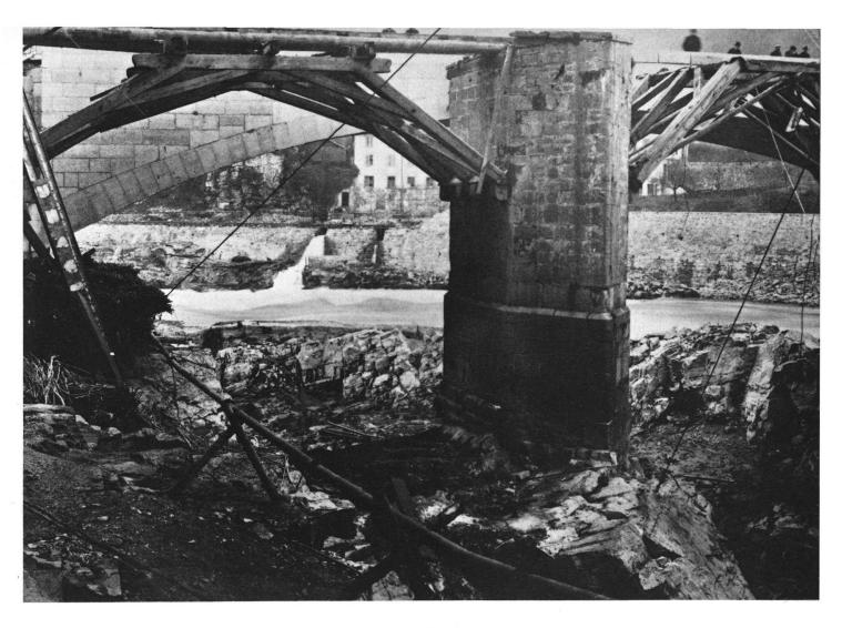
Trapezsprengwerke der ungedeckten Holzbrücke über den Rhein in Laufenburg während der Abbrucharbeiten im Januar 1912. Da hier das gesamte Tragsystem unter die Fahrbahn zu stehen kam, erübrigte sich die Überdeckung.
