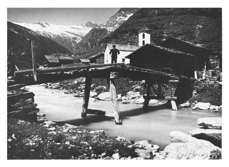
Ehemalige Brücke mit einfacher Balkenlage auf Pfahlböcken in Zervreila bei Vals GR. Die Überreste dieser schmucken Kleinsiedlung liegen heute unter Wasser (Aufnahme 1910). Eine vergleichbare Brücke führte bei Raron/St. German VS über die Rhone. Ähnlich muss man sich auch die Rapperswiler Seebrücke vorstellen, die die Rosenstadt zwischen 1358 und 1878 mit dem Fischerdorf Hurden verband.
