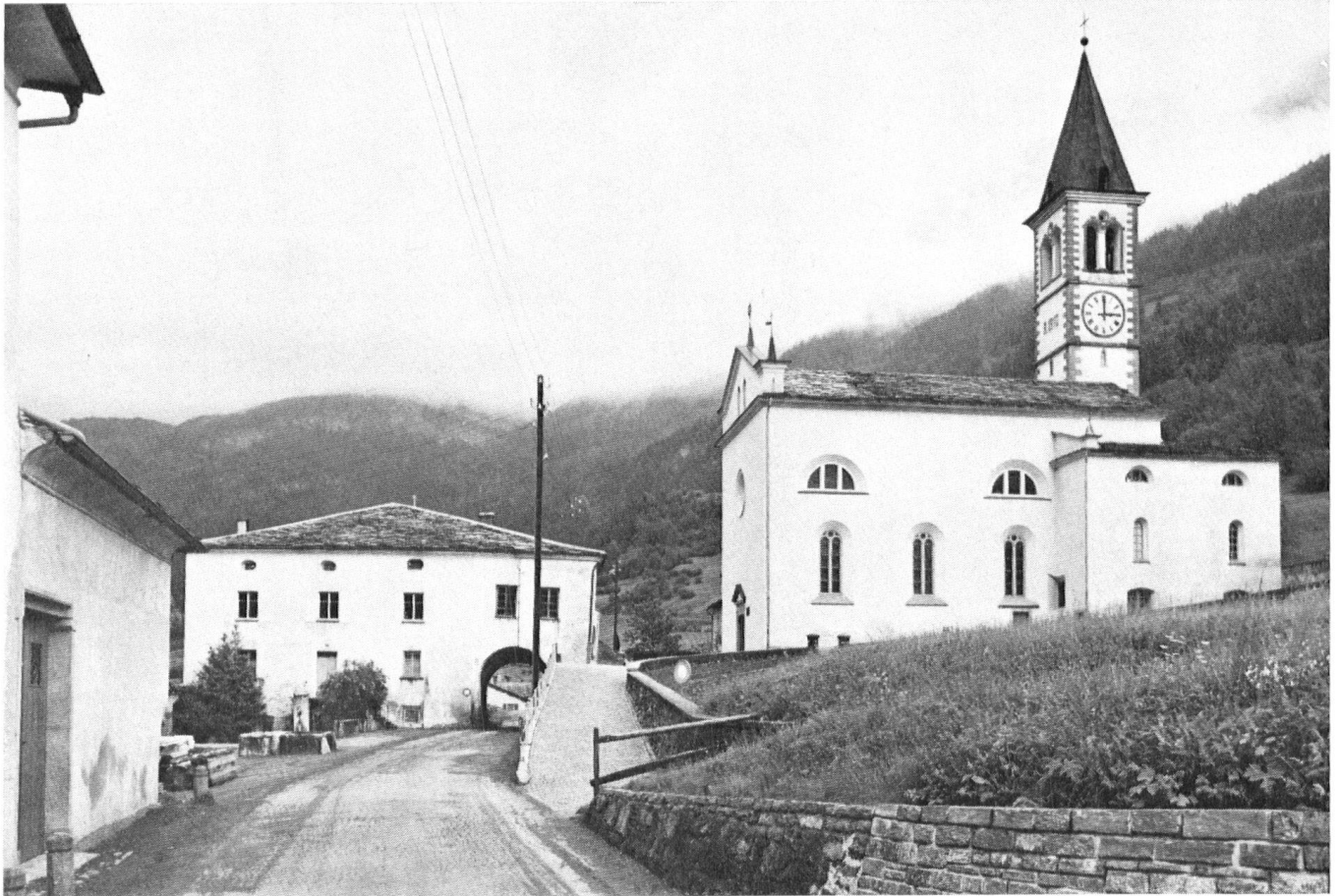
L'église et la maison de paroisse de San Carlo|Poschiavo forment une unité architecturale et donnent au village son caractère particulier. La disparition de la maison de paroisse et son «volt» (arc) très original serit une perte très sensible.
