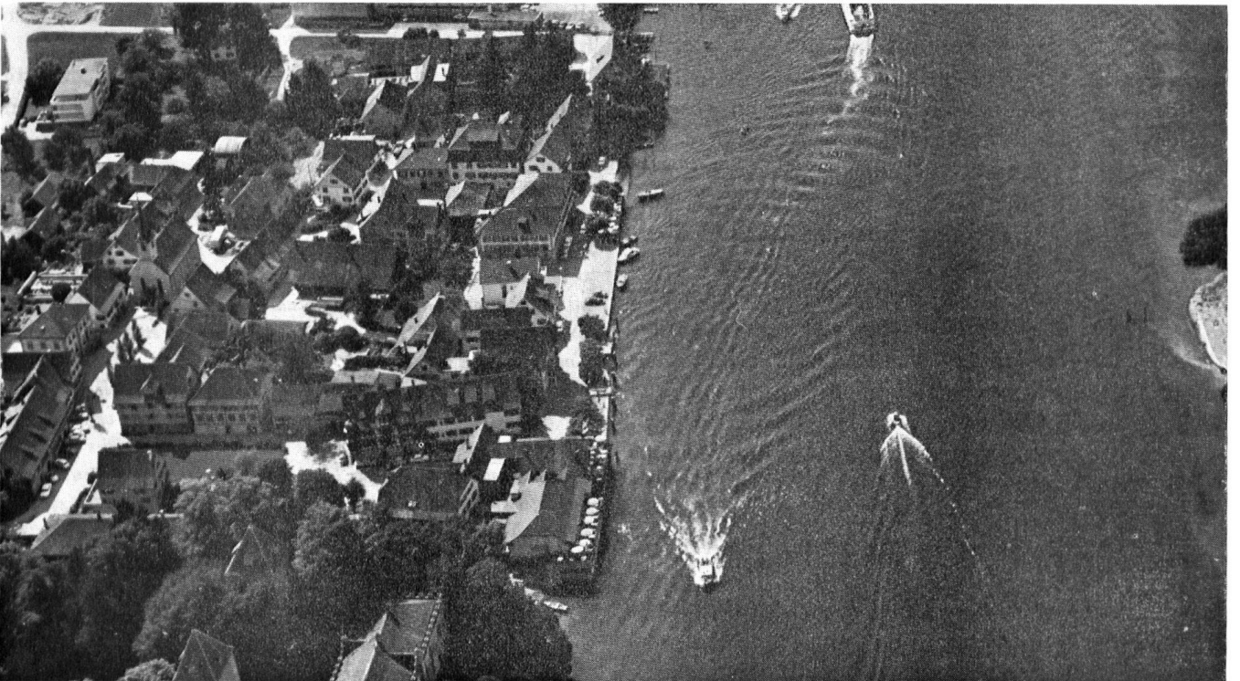
Gottlieben, am Rhein zwischen dem Bodensee und dem Untersee, stellt mit seiner «Drachenburg» und weiteren Riegelbauten ein erhaltenswertes Ortsbild in einer Landschaft von nationaler Bedeutung dar.
