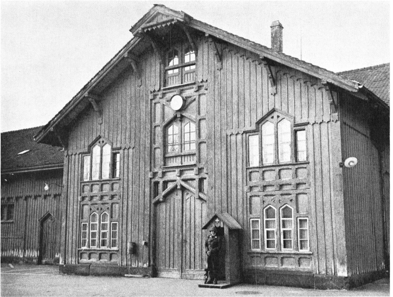
(Abb. 2) Wie der Pavillon, so ist auch die Winterthurer Reithalle 1865 von Karl Bareis (1819–1885) ganz aus Holz erbaut worden. Tüchtige Zimmermannskunst, alte Handwerkstradition, verband sich hier mit dem Historismus, dem Stilgeschmack des 19. Jahrhunderts. Sie trotzte über hundert Jahre lang der Witterung und vertritt als Bautyp auch die Architektur der Schweizer Sängersfesthallen und Kunstgewerbeausstellungen.
