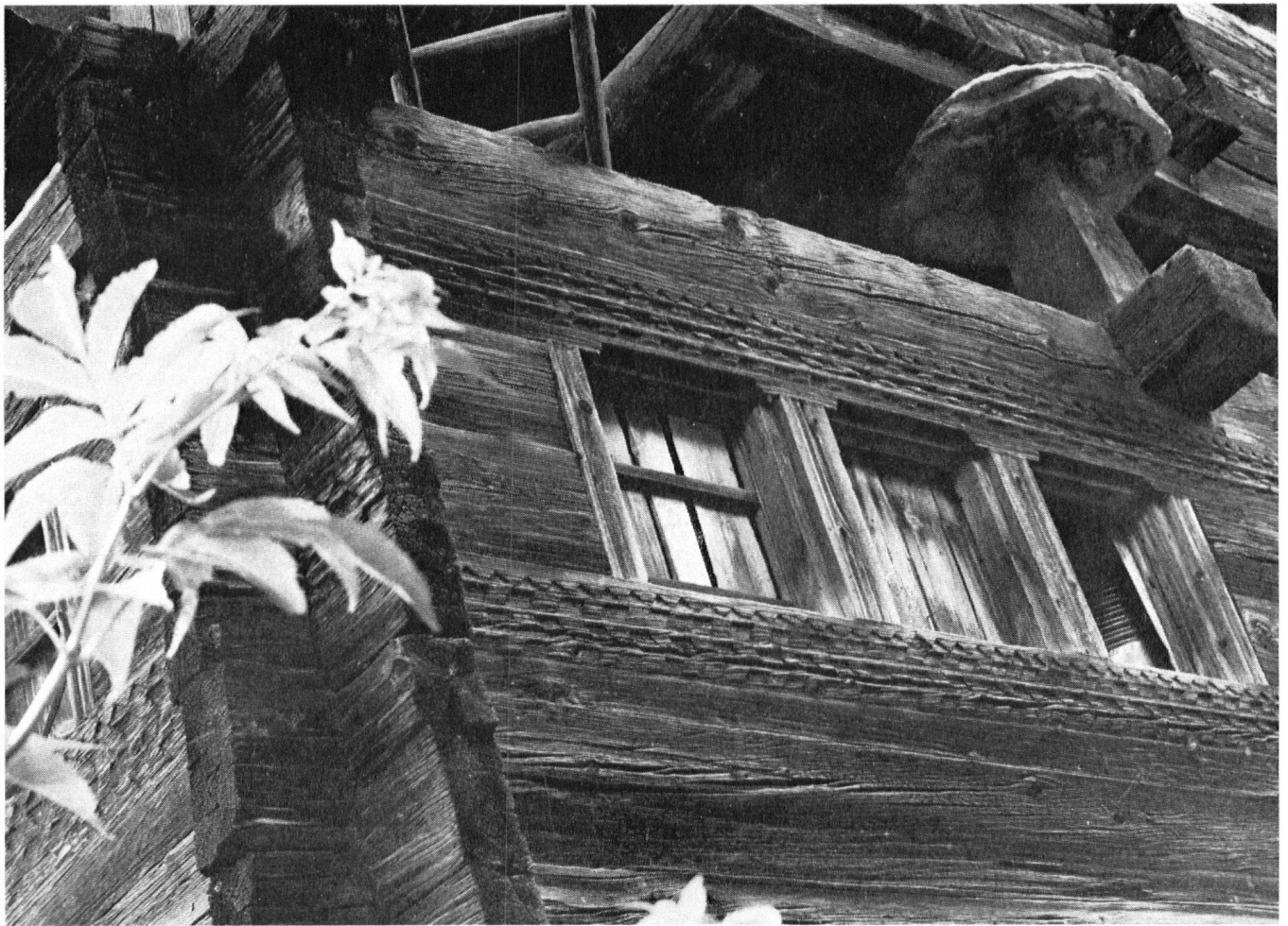
Abb.2. Wie vielfach bei Blockbauten anderer Gebiete ist auch die Fassade des Gommer Hauses, namentlich ober- und unterhalb der Fensterzone, mit Friesborten geschmückt, die sich aber subtil in die geschlossene Fläche der Wand einordnen. Die Formen dieser Flachschnitzereien wechselten binnen Jahrzehnten, so dass sie dem Fachmann heute eine wertvolle Hilfe bei der Datierung der Häuser bedeuten.
