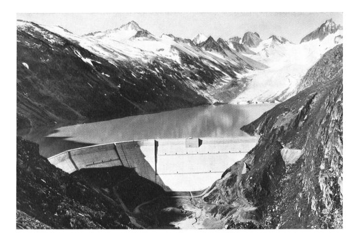
Le plus élevé – il touche le glacier – des bassins d'accumulation de la vallée de l'Aar, dans la région du Grimsel. Le mur de béton a un aspect dur. Suivant la configuration des lieux et la nature géologique des terrains, on construit un mur (incurvé ou rectiligne) en béton comme ici, ou une digue recouverte de terre gazonnée, ce qui est plus heureux pour le paysage.
