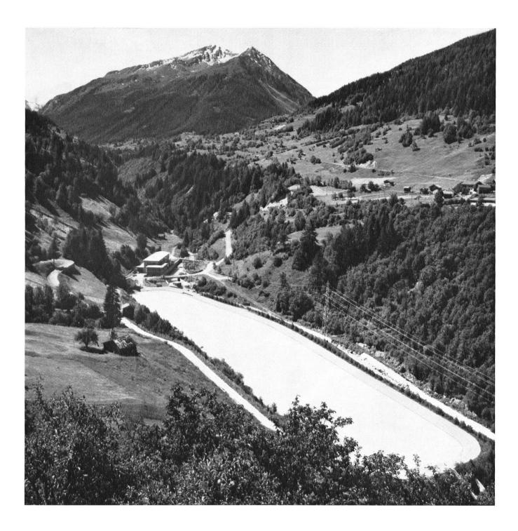
Les bassins de compensation (ici, celui de Vissoie, dans le val d'Anniviers) sont indispensables dans une installation hydro-électrique à plusieurs étages; car leur eau est nécessaire aux heures de pointe. Du point de vue du paysage, on ne peut que déplorer les constructions qui abritent les vannes, généralement situées au fond d'une vallée. qu'on peut se demander si, quelques années plus tard, on n'aurait pas renoncé à ce projet.
