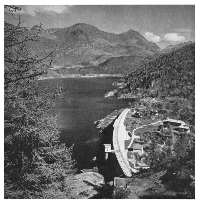
Il y a 50 ans, les C.F.F. firent du lac Ritom, tout au nord du Tessin, un bassin d'accumulation, en surélevant son niveau par un barrage. Vers 1950, seconde surélévation.
