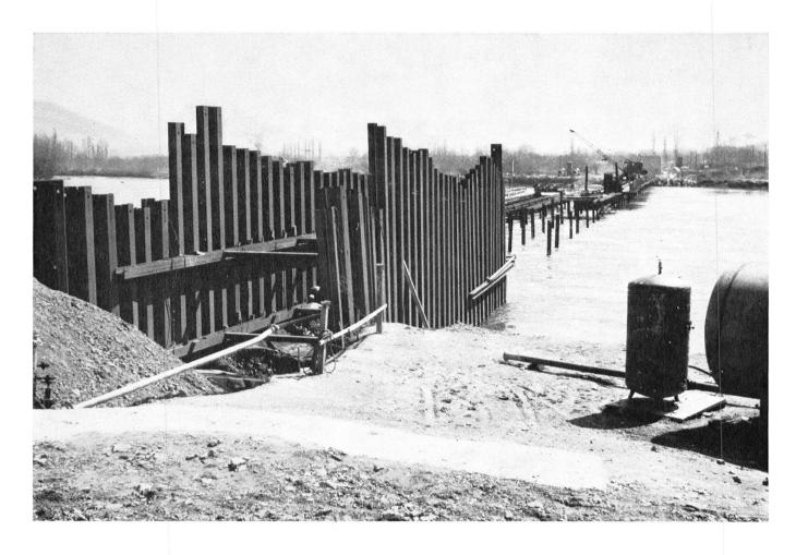
Le dernier barrage de retenue qui était encore susceptible d'être réalisé entre Schaffhouse et Bâle était celui de Koblenz. La construction de l'usine avait été décidée et les rapides (Koblenzlaufen) devaient être sacrifiés. Pour des raisons économiques et de rentabilité les travaux furent arrêtés à leur début et le chantier levé après remise en état du site.
