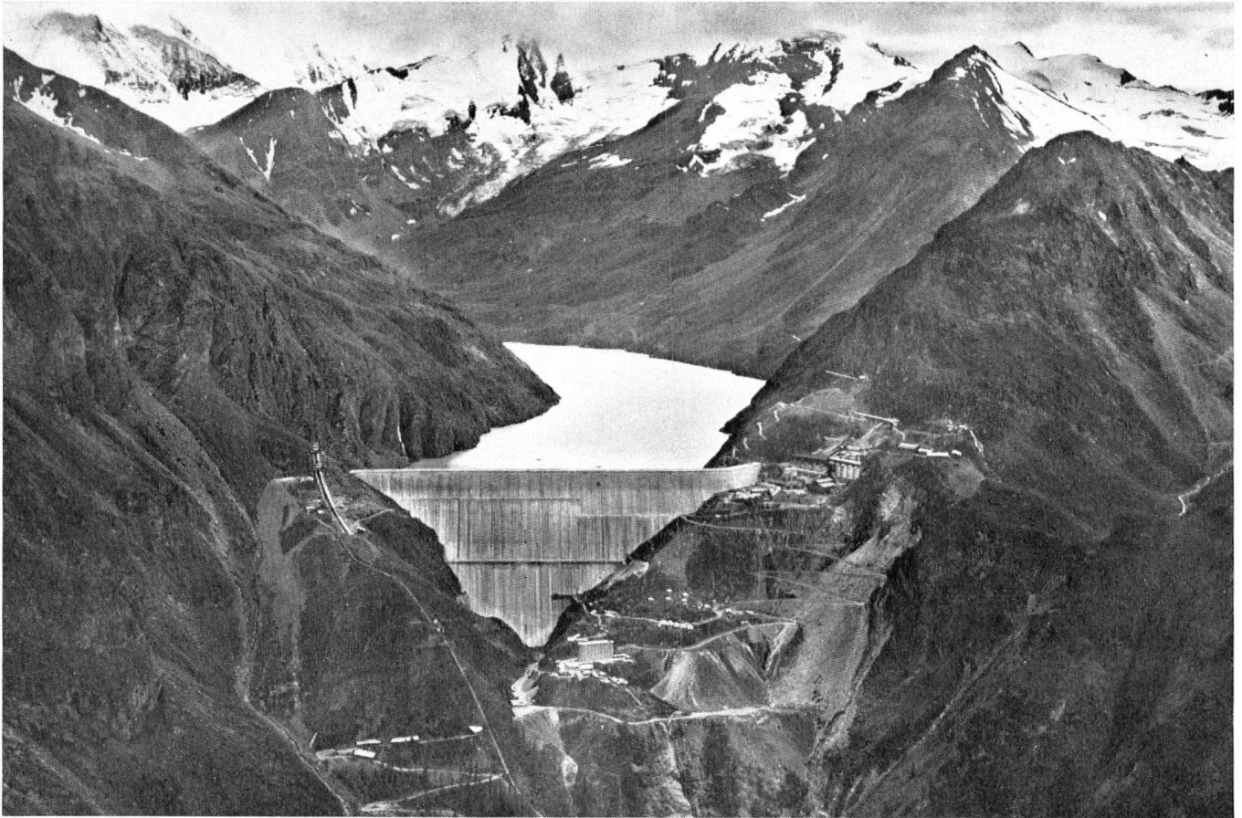
Die 284 m hohe Schwergewichtsmauer der Grande Dixence im Wallis, eine der gewaltigsten Bauten dieser Art überhaupt, dämmt einen 5 km langen, bis 400 Millionen Kubikmeter Wasser speichernden Stausee ab, der sich fjordartig in die Fels- und Eisregion des Val-des-Dix bettet.
