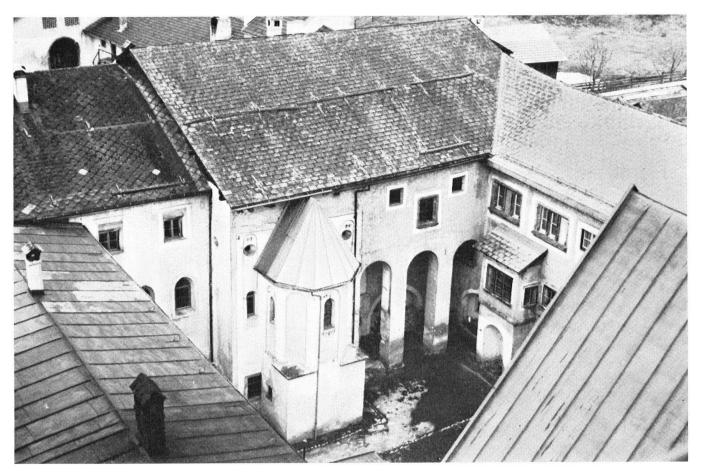
Die Dachlandschaft des Klosters und der Blick in die Höfe enthüllen die baulichen Schäden und den teilweise bedenklichen Zustand. Von Ziegeln und Schindeln bis zu Blech und Eternit fehlt kein Bedachungsmaterial. In der Mitte der Pfalzflügel des Bischofs Norpert, der im ausgehenden 11. Jahrhundert hier sein Exil verbrachte, und die romanische Doppelkapelle (unten Ulrichs-, oben Nikolauskapelle).
