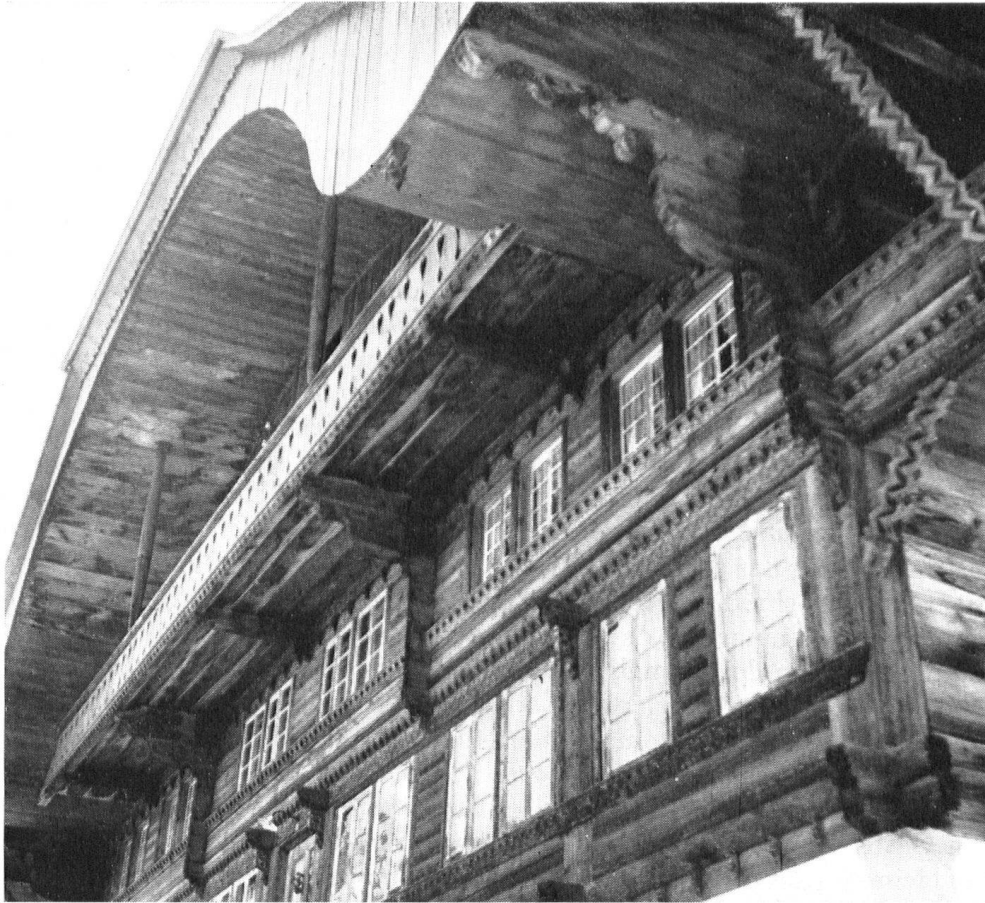
Bei aller äussern Wucht ist das Grosshaus sehr leicht konstruiert. Einen besondern Schmuck stellen die Balken- schnitzereien an der Hauptfront dar.
