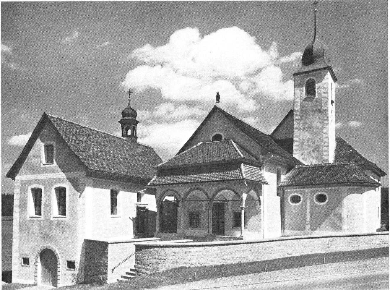
Die arg vernachlässigte Wallfahrtskapelle St. Jost in Blatten LU ist nach der durchgreifenden Innen- und Außenrestaurierung, zu welcher auch der Heimatschutz seine Beiträge spendete, recht eigentlich auferstanden. Die ungewöhnlich schöne Baugruppe wirkt als Fergate im freien Landschaftsbild.
