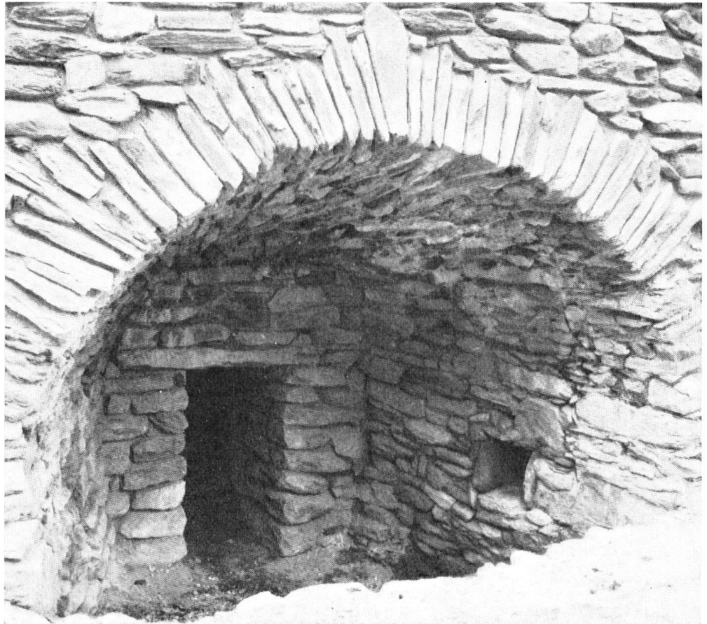
Voûte d'accès et tuyère (ouverture pratiquée à la base d'un four pour le passage de l'air soufflé).
