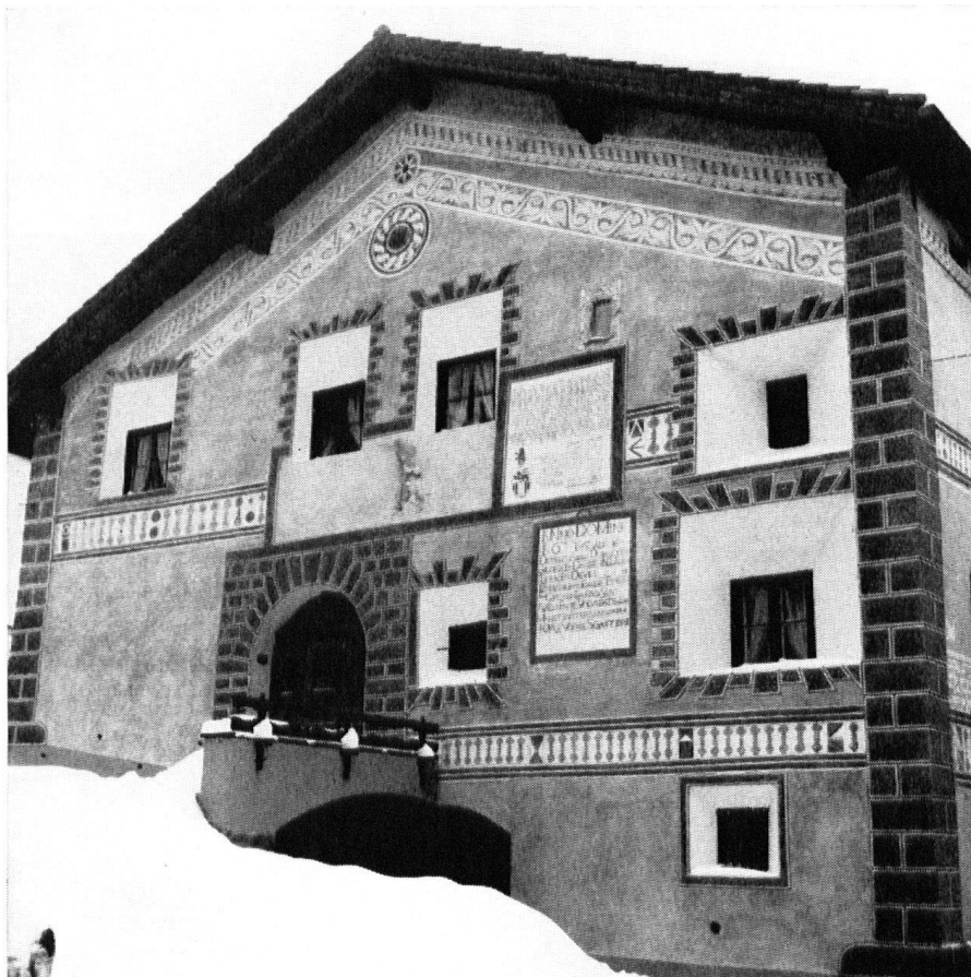
Et voici ce qu'en a fait le propriétaire actuel, à qui le Heimatschutz a voté un subside et qui avait confié la direction des travaux à l'architecte C. Kőnz à Zuoz. – Remarquer la riche décoration par graffiti.
