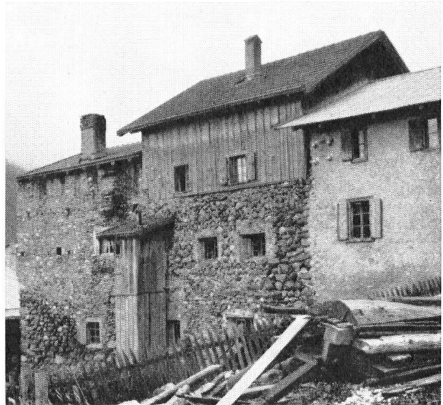
Deux habitations-tours, se touchant, datant du moyen âge, à Salouf, près de Tiefencastel.
