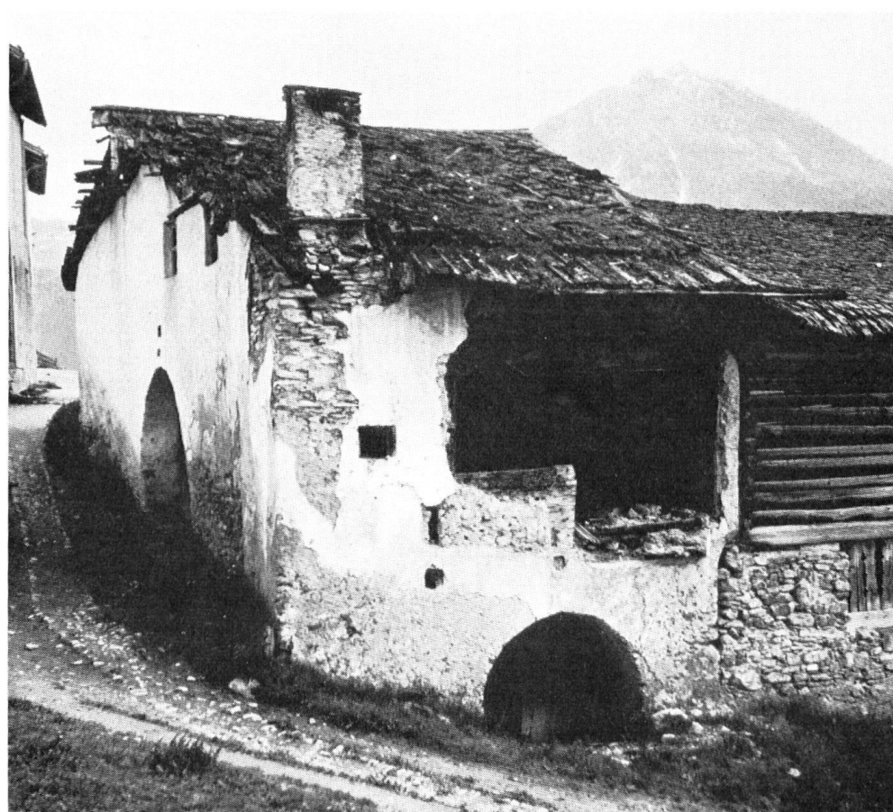
Une partie du mur s'est effondrée, ce qui permet de voir à l'intérieur les solives de bois d'arole. — Cette maison, aujourd'hui, n'existe plus.
