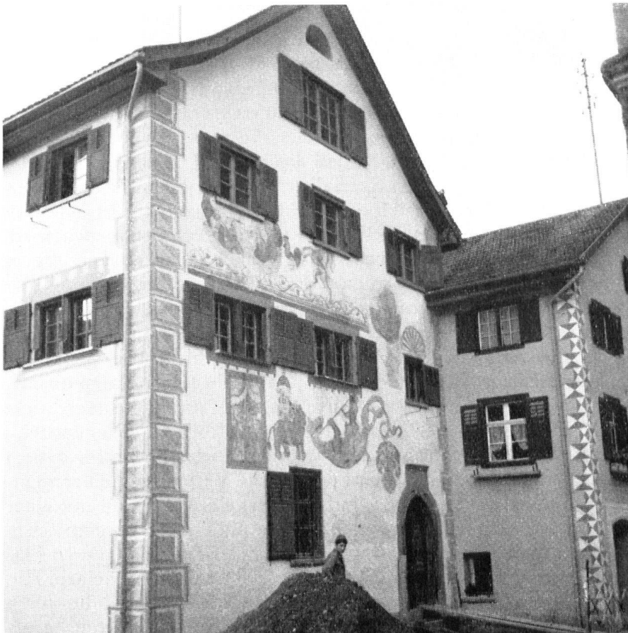
Nach jahrelangen Bemühungen ist es dem Bündner Heimatschutz und der kantonalen Denkmalpflege gelungen, das Haus zu restaurieren und in seinem früheren Zustand zu erhalten.
