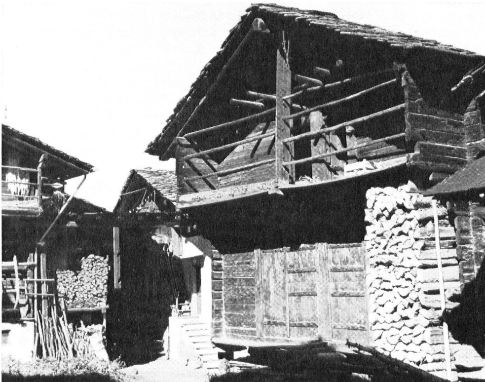
Beaucoup de raccards seront aménagés, ce qui se verra naturellement de l'extérieur (voir page précédente), mais la structure du village est maintenue, avec l'irrég- ularité et l'étroitesse de ses rues. – Il est souhai- table que les raccards transformés restent pro- priété des gens du village.
