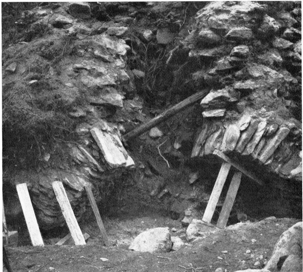
Einem Schutthügel ähnlich, erhoben sich die Reste des Schmelzofens vor der Restaurierung. Unter dem Boden, bis in 3 m Tiefe, war die Umfassungsmauer jedoch vollkommen intakt, ebenso der einstige Ofenschacht in der Mitte.
