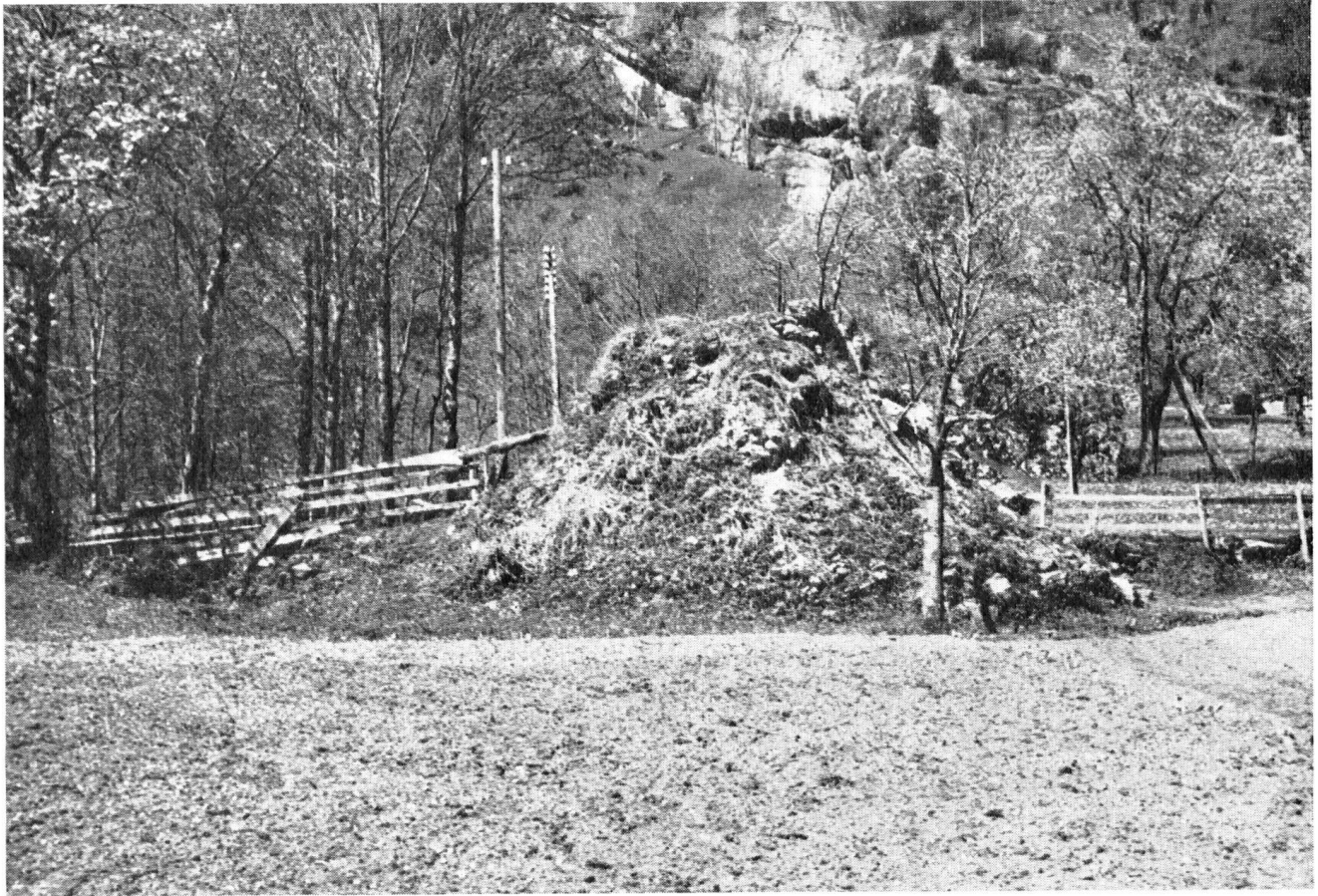
Einem Schutthügel ähnlich, erhoben sich die Reste des Schmelzofens vor der Restaurierung. Unter dem Boden, bis in 3 m Tiefe, war die Umfassungsmauer jedoch vollkommen intakt, ebenso der einstige Ofenschacht in der Mitte.
