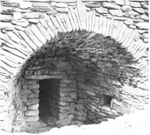
In dieser Form ist der Ofen durch das Restaurationswerk wiedererstanden. Die Öffnung bezeichnet die Stelle des einstigen Abstichs; nicht sichtbar (rechts hinten) ist die Formöffnung.
