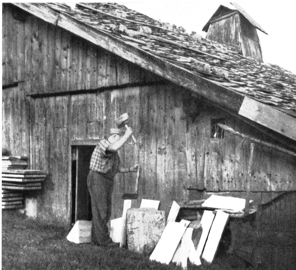
M. F.-E. Sauser, de La Chaux-du-Milieu, est le dernier fabricant de bardeaux du canton. Le voici à l'œuvre devant sa ferme de la Croix, dont le toit, on le voit, prêche d'exemple. Il a fendu à lui seul 15 000 planchettes. Une entreprise spécialisée de Sumiswald a fait l'autre moitié du stock nécessaire.
