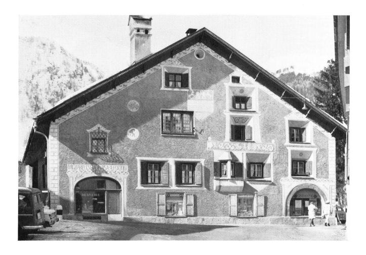
Hier genügten die früheren repräsentativen Hauseingänge, ohne Vergrößerung, zum Einbau einer modernen Metzgerei und eines Kolonialwarenladens. Die jetzige Hauseingangstüre wurde, entsprechend der neueren Zeit und der bescheideneren Einwohner, ganz klein auf einer Seitenfassade angebracht.
