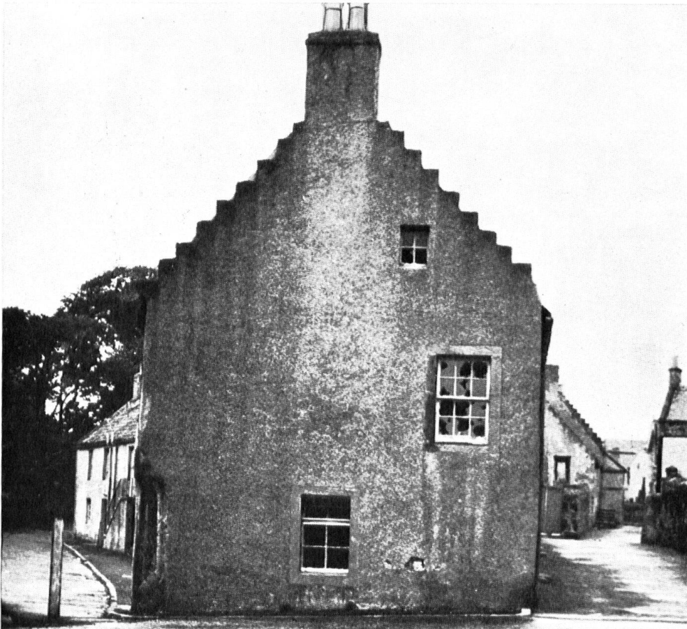
A Crail, sur la côte de l'East Neuk of Fife, la première maison achetée par le « Heimatschutz » écossais, avant sa restauration.
