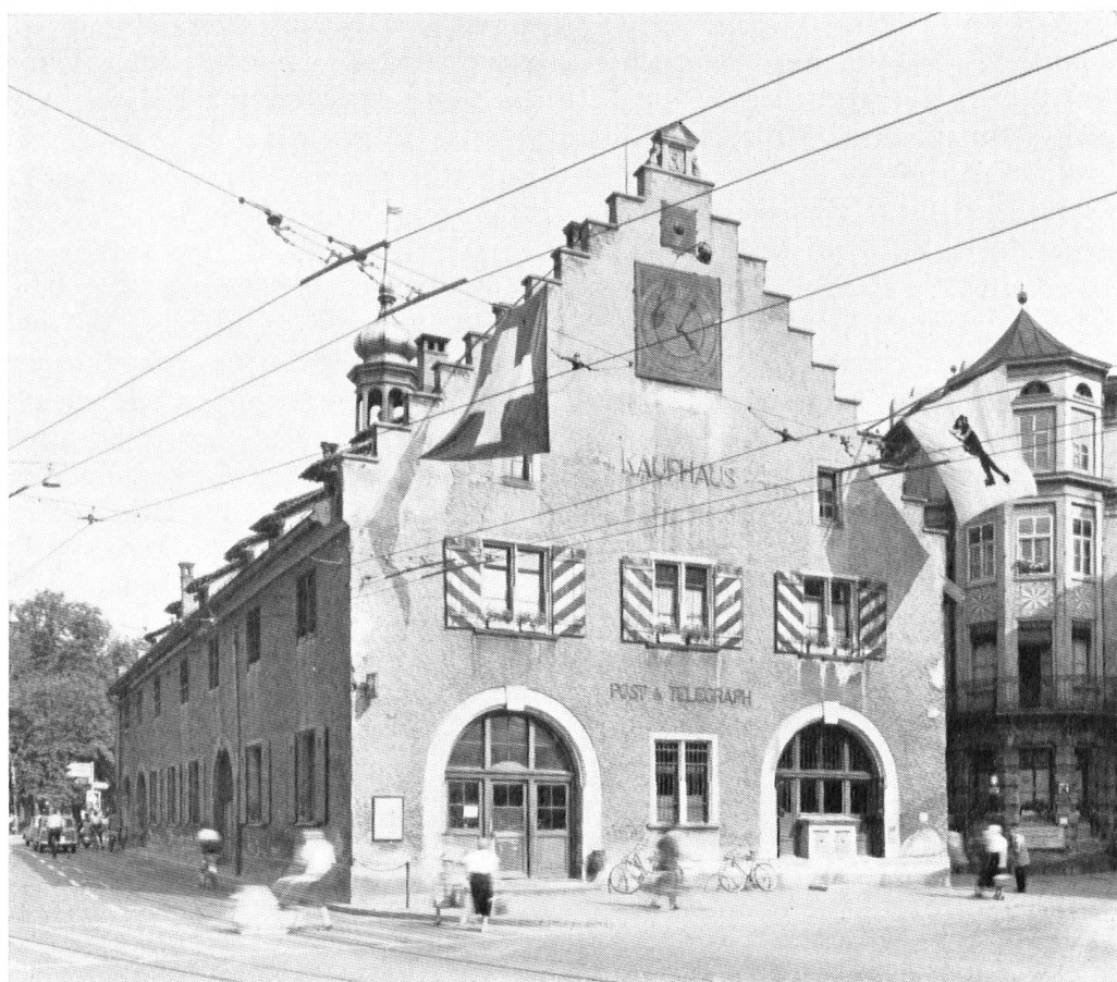
Façade ouest avant la restauration. Mauvaise structure architecturale. Au rez-de-chaussée quelques verrues. Crépi grisâtre et écaillé.
