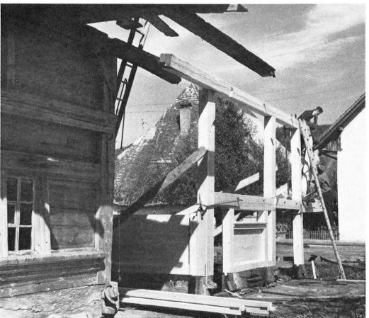
Une nouvelle charpente de l'étable – car l'ancienne a été anéantie par le feu – est mise en place, conformément à la méthode et aux techniques traditionnelles.
