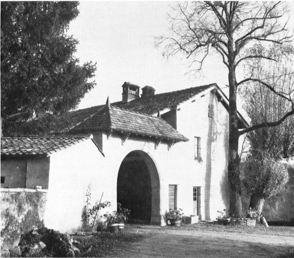
Ein mit Hilfe des Heimatschutzes erneuer- ter Bauernhof in Malval.
