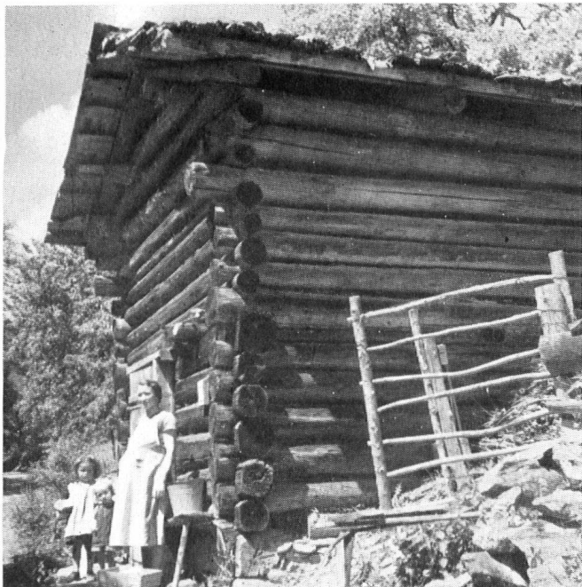
Die notwendige Ergänzung zu den Wohnhäusern bilden auch in den Freilichtmuseen die landwirtschaftlichen Hilfs- und Nebengebäude. – Wir zeigen einige Beispiele: oben links ein aus geschälten Tannenstämmen „aufgetrölter“ Prättigauer Gaden; rechts ein Kornspeicher aus Saas Fee auf gemauerten Stelzen (Schutz des Kornes gegen Mäusefraß).
