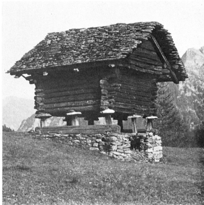
Die notwendige Ergänzung zu den Wohnhäusern bilden auch in den Freilichtmuseen die landwirtschaftlichen Hilfs- und Nebengebäude. – Wir zeigen einige Beispiele: oben links ein aus geschälten Tannenstämmen „aufgetrölter“ Prättigauer Gaden; rechts ein Kornspeicher aus Saas Fee auf gemauerten Stelzen (Schutz des Kornes gegen Mäusefraß).
