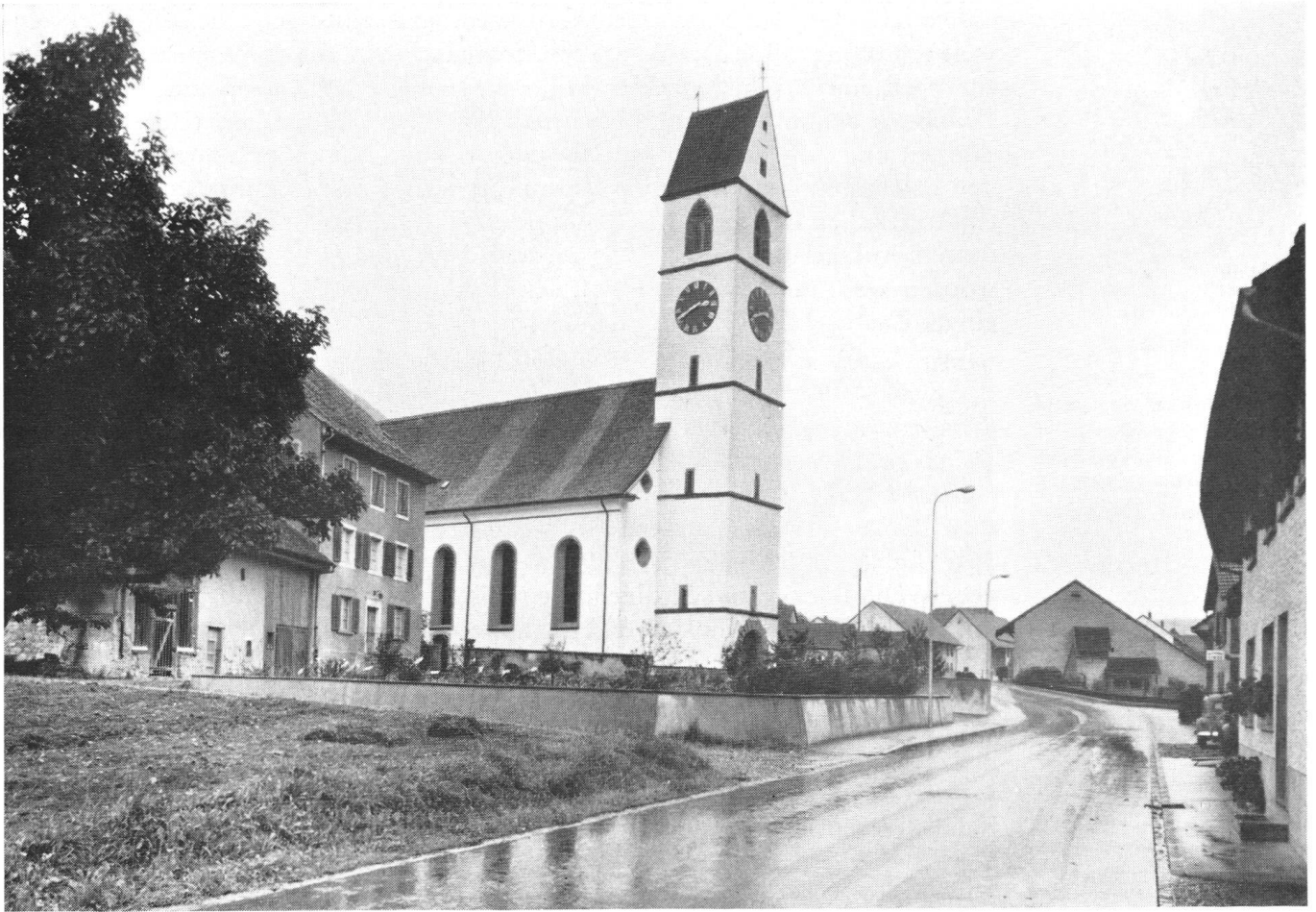
Kirche Mettau; nach Abbruch des Schwesternhauses (Wieskapelle).
