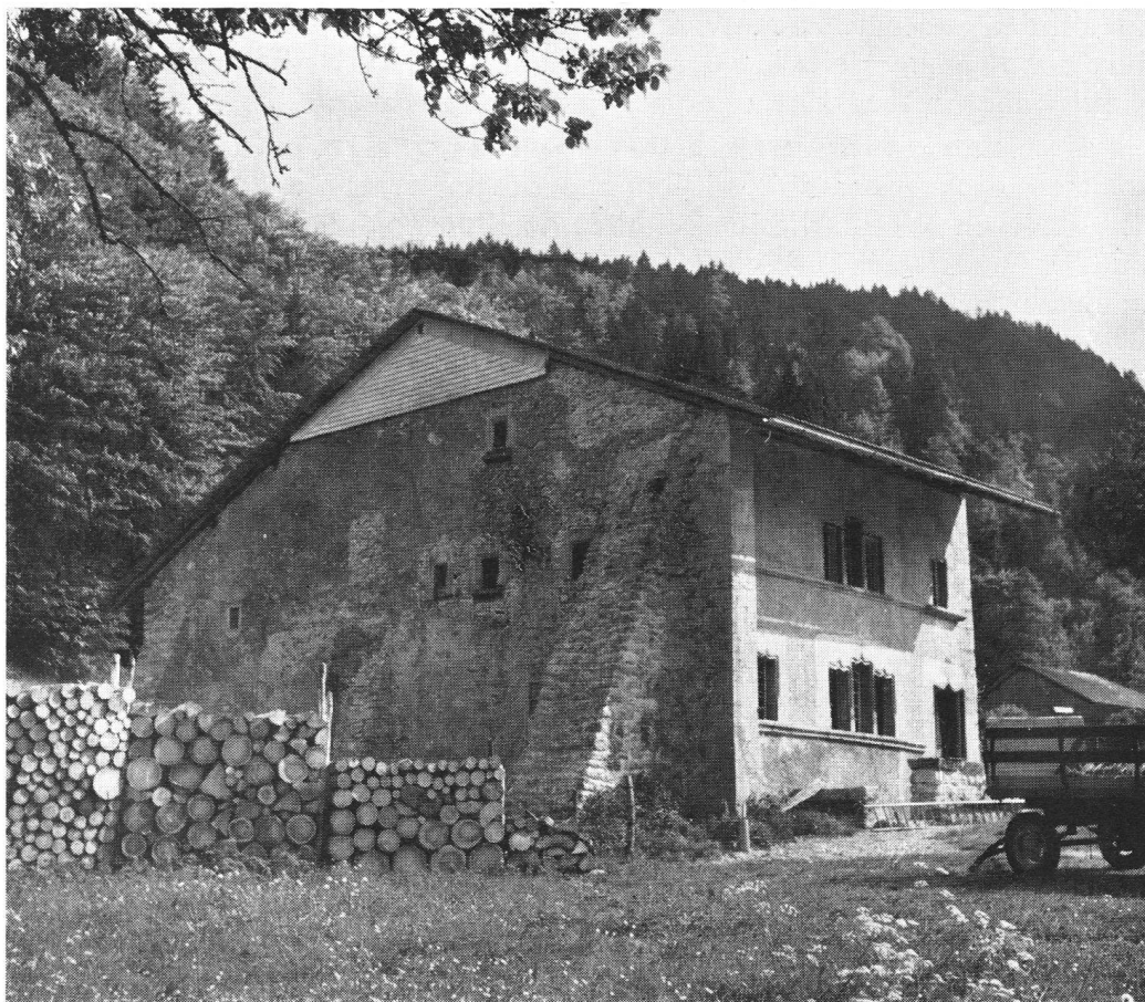
Grandvillard. Das mit Hilfe des Heimatschutzes erneuerte Haus des Fähnrichs, gesehen von seiner trotzigen Wetterseite.
