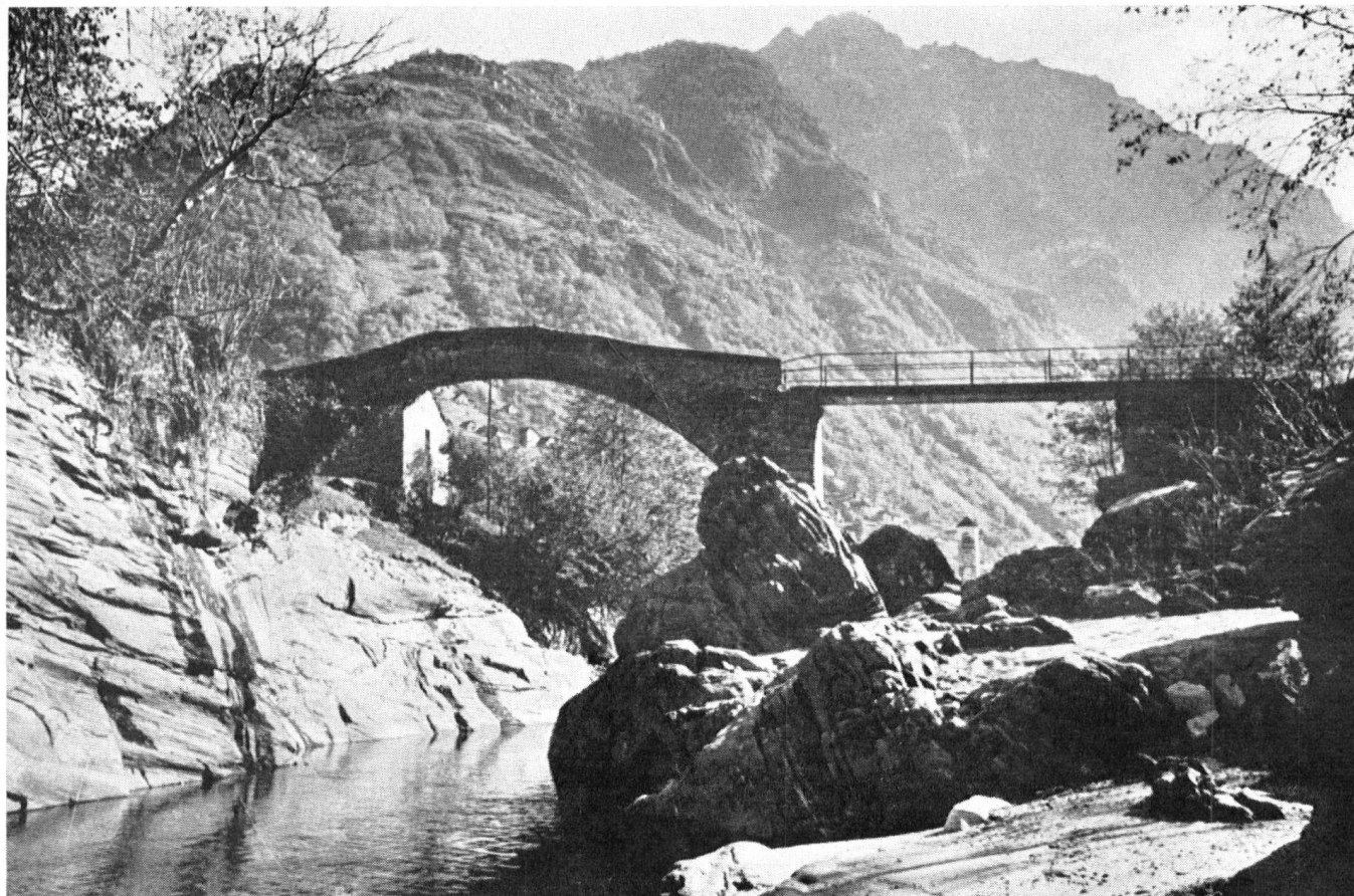
Le pont mutilé. L'arche détruite par le torrent avait été remplacée par une misérable passerelle.
