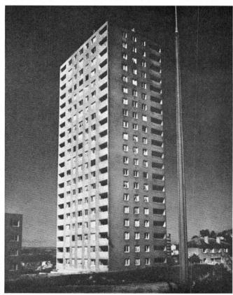
Deux mauvais exemples: Il ne suffit pas de superposer dix ou vingt fois la même tranche-étage.
