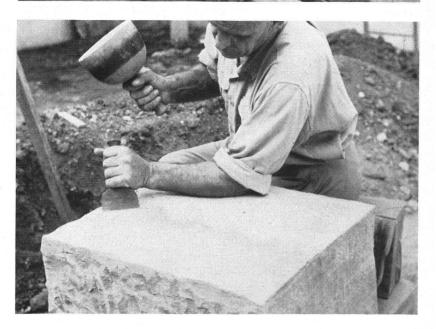
Au XVe siècle, à côté du marteau plat, on se mit à user du ciseau large fer et de la massette. Grâce à ces nouveaux outils, l'appareillage de surfaces plus régulières et très variées devint possible; le rebord disparut. Au cours du XVIe siècle, le pic à deux pointes et le marteau plat ne furent plus guère employés.
