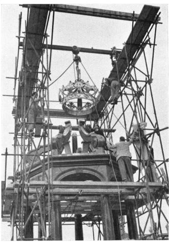
Die 3 Meter hohe, an 5 Zentner schwere, feuervergoldete neue Krone des Marienbrunnens, Arbeit von Goldschmied Adolf Bick in Wil SG. Das Bild rechts zeigt den Aufzug der Krone an einem besonders aufgebauten Stahlgerüst mit Laufkran.
