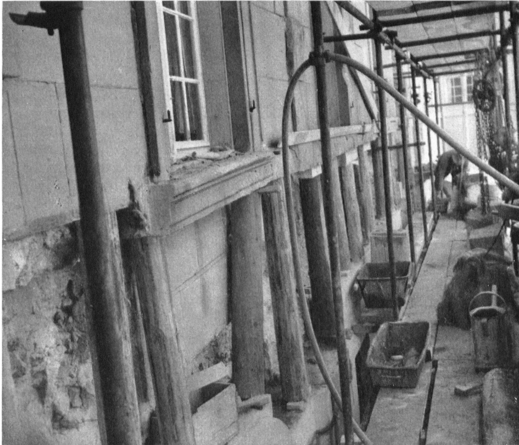
Blick ins Baugerüst. Die an die Kirche anschließende Fassade, die sich gesenkt hatte (Fenstersimse) wird ins Gleichgewicht gebracht und neu verkleidet.
