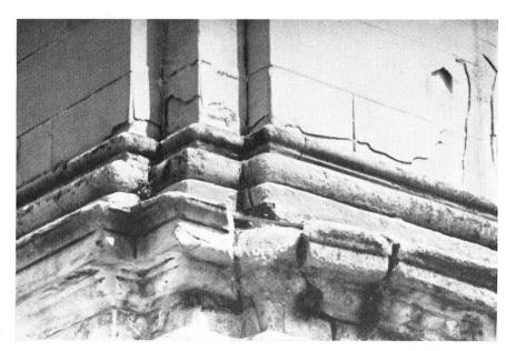
Die Ecke der Sockelpartie am Nordturm. Das Bild zeigt, wie ganze Teile des Gesimses abgesprengt und abgefallen waren.
