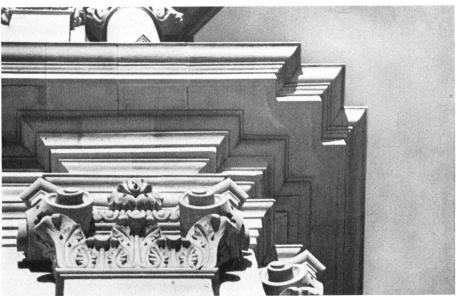
Nahaufnahmen nach der Erneuerung: Wände, Kapitelle, Gesimse, z. T. aus dem noch gesunden Stein neu herausgearbeitet, z. T. durch nachgearbeitete Stücke ersetzt, strahlen wieder wie am ersten Tag. Man versteht, daß das Kloster stolz darauf ist. Die Auffassung der Denkmalpfleger bleibt nach wie vor geteilt.
