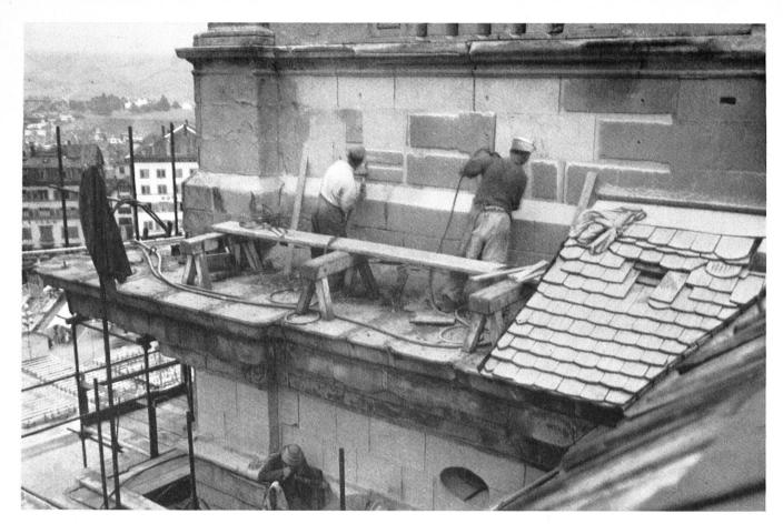
Diese beiden Bilder illustrieren die Verwendung der (Bildhauer-)Preßlufthämmer. Um sie vor allem entbrannte die Meinungsverschiedenheit zwischen dem Stift und den eidgenössischen Experten (s. Text). Auf dem obern Bild ist das sog. Scharrieren, d. h. Zurückhauen der Obersläche der Mauerquadern zu erkennen. Wir verweisen auch dieserhalb auf den erläuternden Text.
