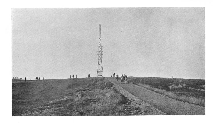
Der gesäuberte Rigigipfel mit dem eingezeichneten, 27 m hohen Ultrakurzwellen- und Fernseh-Sendeturm. Die Skizze ist nur maßgebend für die Höhe, nicht aber für die Gestaltung des Mastes. Nach Angabe der PTT könnte auch ein abgespannter Mast oder eine Rohrkonstruktion in Betracht gezogen werden.
