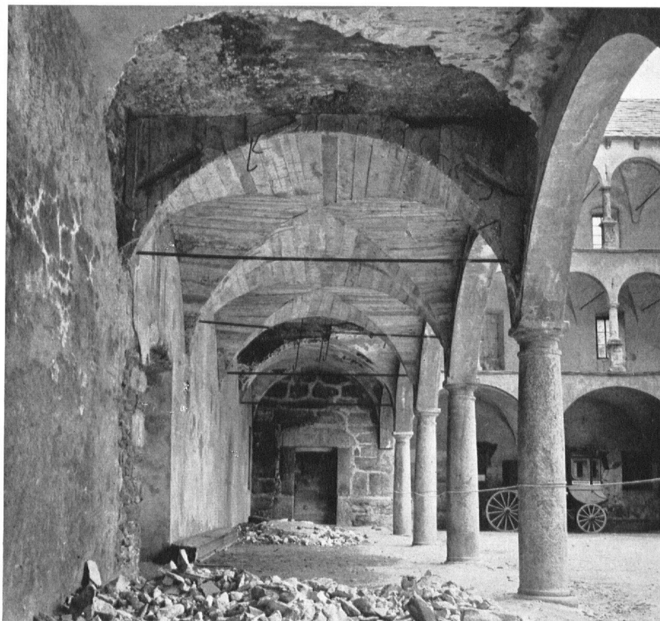
Dans la cour d'honneur, des voûtes s'effondrent (été 1955). Il est urgent de porter secours à l'édifice qui menace ruine.
