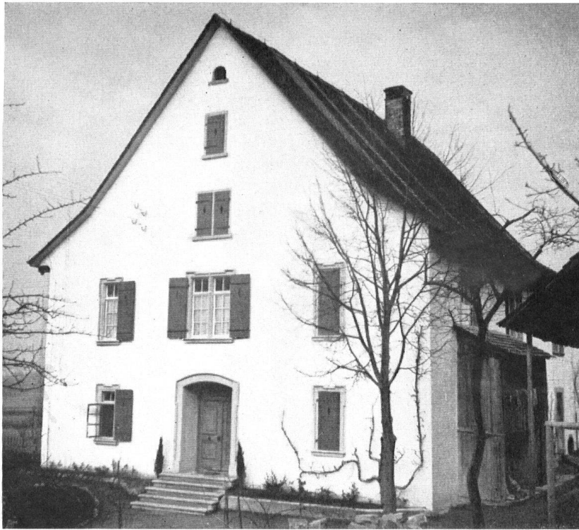
Ein liebenswertes vom Schaffhauser Heimatschutz unterstütztes Werk: die Erneuerung des »Schlößchen« Wiesholz bei Ramsen. Das Innere enthält eine getäferte Stube mit reichem Ofen und schöner Stuckdecke.
