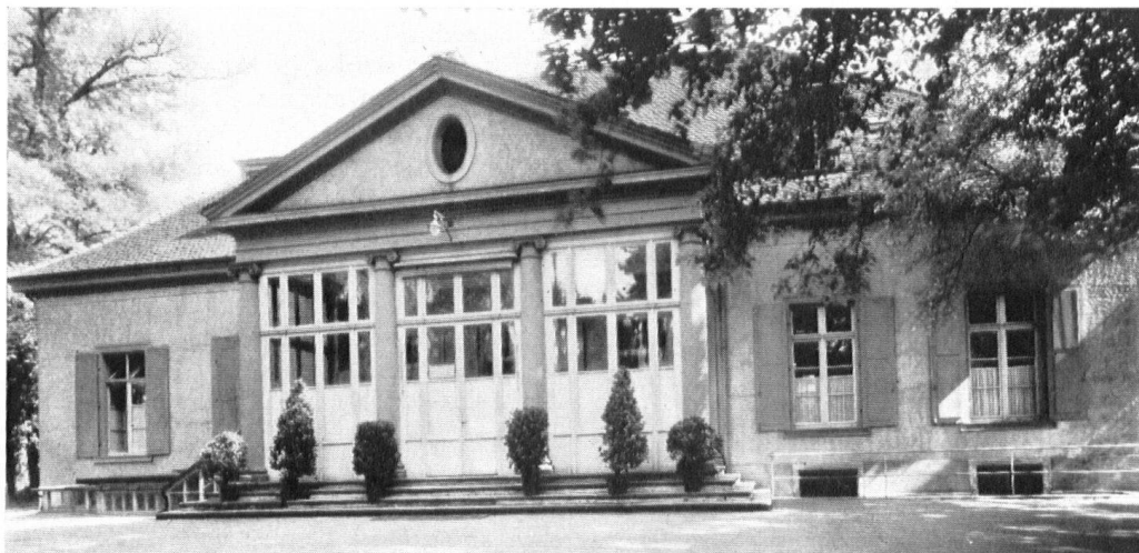
Das sog. Sommercasino in Basel, dessen Rettung ein gegenwärtiges Hauptanliegen der Sektion Basel-Stadt ist.
