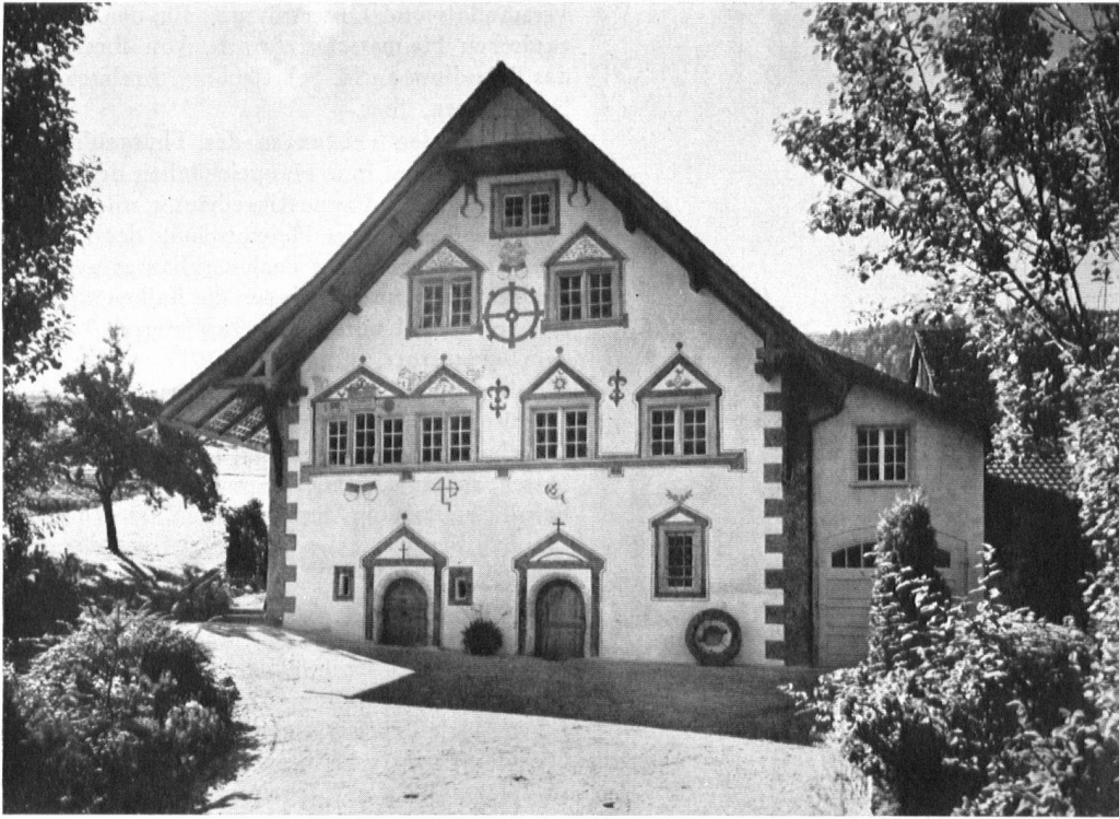
Von ihren zahlreichen Werken zeigt die Sektion Solothurn die mit ihrer Hilfe erneuerte Mühle in Ramiswil am Paßwang (1596). Die Malereien waren nur noch in Spuren sichtbar; der Anbau mit der Garage mußte leider stehen bleiben.
