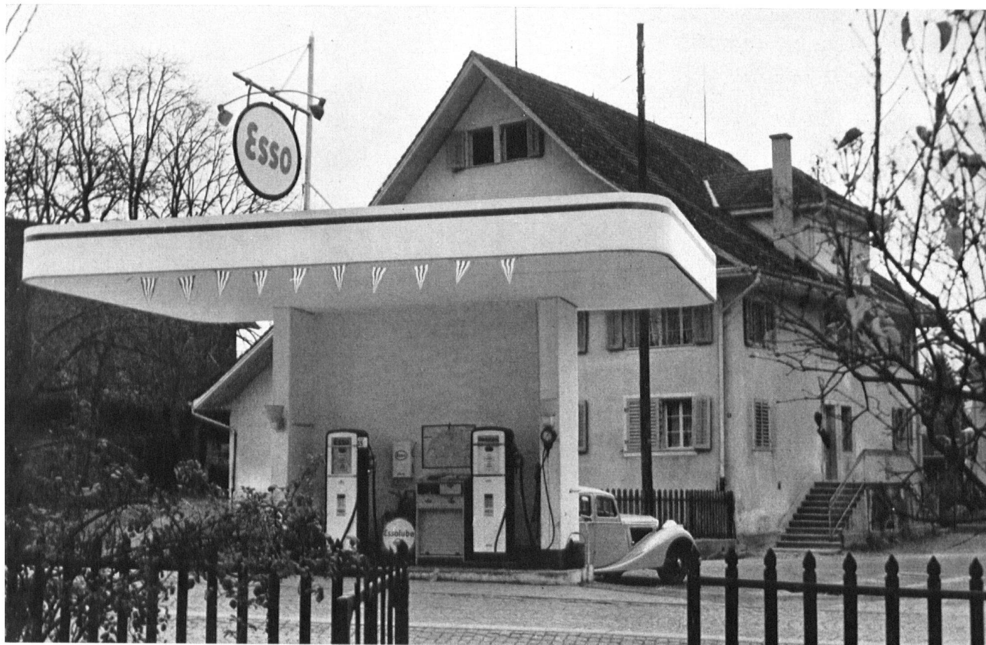
Prétentieuse verrue devant une maison bourgeoise de Suisse centrale (route Zurich—Lucerne). L'épaisseur de l'avant-toit n'est qu'un trompe-l'œil, fait d'une feuille de tôle.
