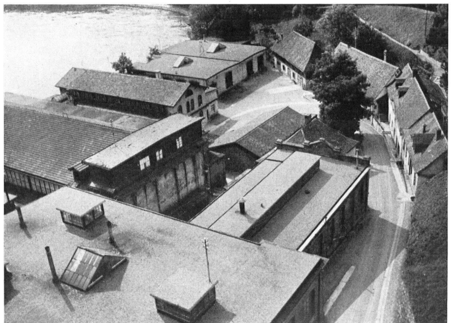
Die nun abgetragenen Fabrikgebäude, rechts im Bild die bis jetzt versteckte Zeile der alten Häuser.
